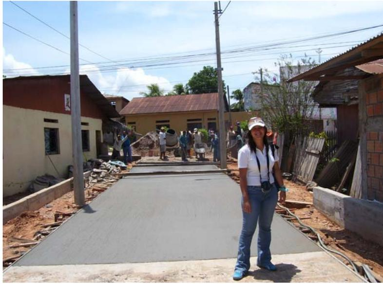
En esta imagen se observa el paño ya vaceado de 14m seguido sin dejar junta de dilatación.
