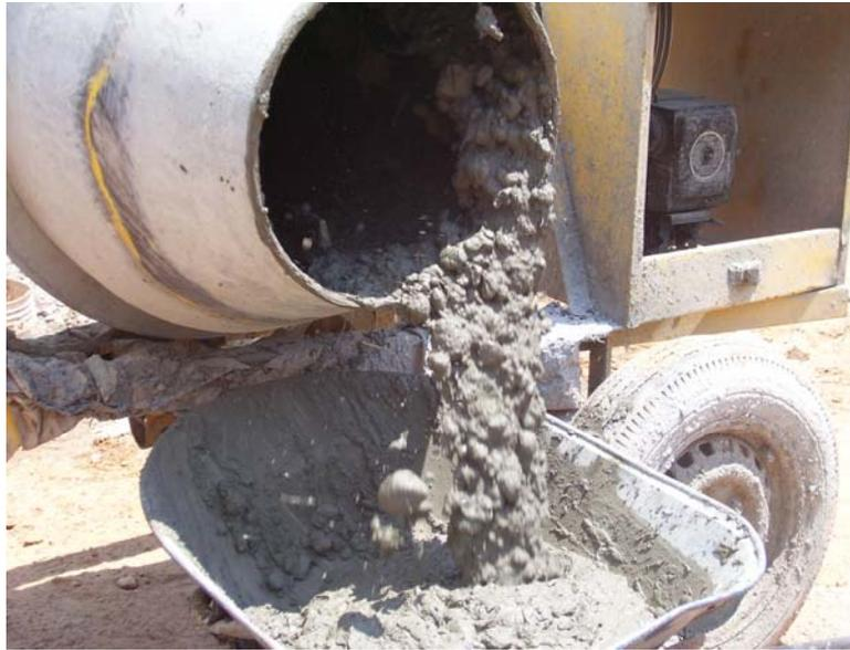
Se aprecia llevando la mezcla para ser vaciado en los paños.
