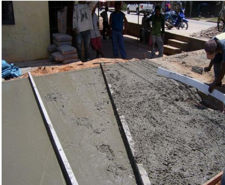
Se aprecia el vaceado del paño de 14 m seguido sin dejar junta de dilatación.
