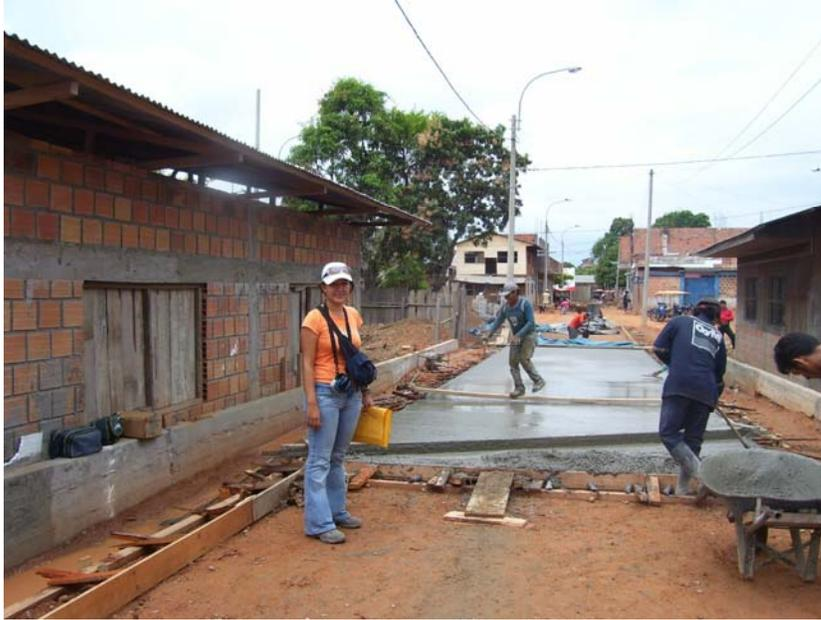
Se puede apreciar en esta imagen el vaciado de uno de las losas de pavimento del tercer pasaje La Torre- Pucallpa, es aquí en esta losa se vacio un paños de 14,2 metros de largo con 3,6 m de ancho, se coloco la junta de contracción (tipo 2) a los 8 metros, y a los 14,0m se coloco junta de expansión contra otras estructuras
