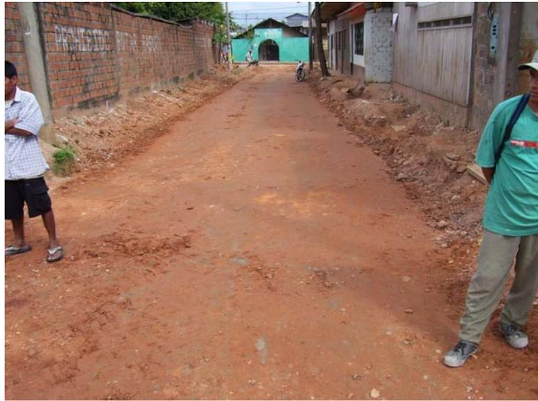
Se puede apreciar en que la base ya está compactada, listo para encofrar y realizar el vaceado, es muy importante una buena compactación.
