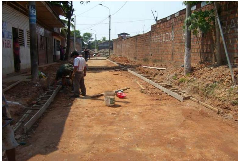
Se puede apreciar que la base ya está compactada, se esta encofrando para luego realizar el vaciado.
