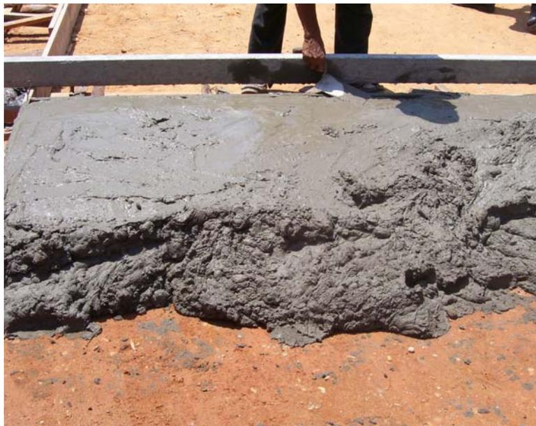
Se aprecia la mezcla vaciada en los paños, hay una homogenidad en la mezcla.
