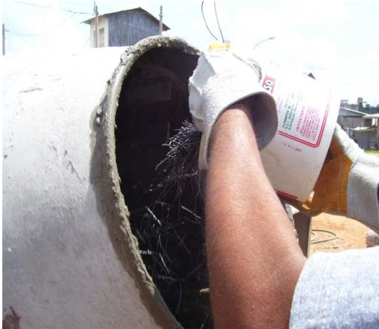
Se aprecia la introducción de las fibras en la mezcladora, ya cuando se agregó los otros agregados.
