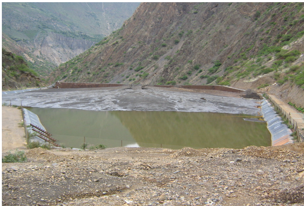
Drenes verticales tipo Quenas para drenaje de las aguas del relave que escurren hacia la parte baja de la presa
