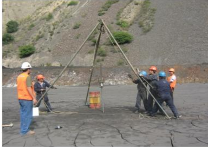
Realización del ensayo de Penetración Standard (SPT)
