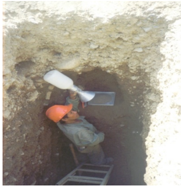
Colocación del aparato de Densidad sobre la placa
