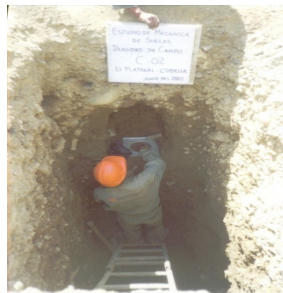
Colocación de la de placa de base
