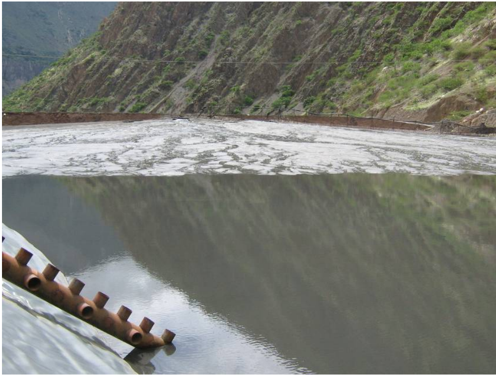
Drenes verticales tipo Quenas para drenaje de las aguas del relave que escurren hacia la parte baja de la presa
