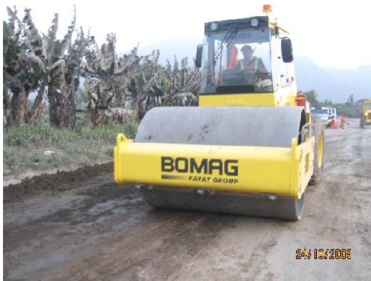
Imagen 1. Compactación en la carretera Viru – Zaraque, Provincia: Viru, Departamento: La Libertad.
