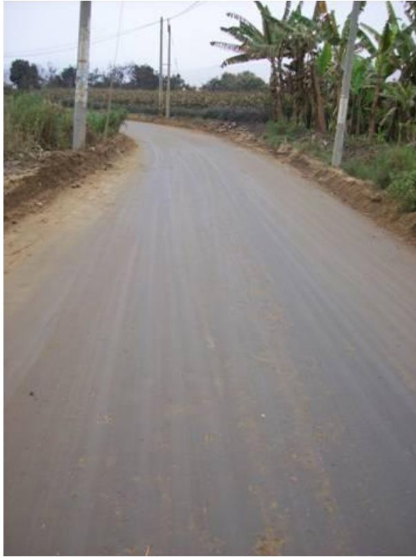
Imagen 10. Condición final de la vía.
