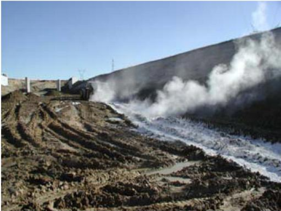
Imagen 4. Evaporación producida en un suelo completamente encharcado al extender cal viva.
