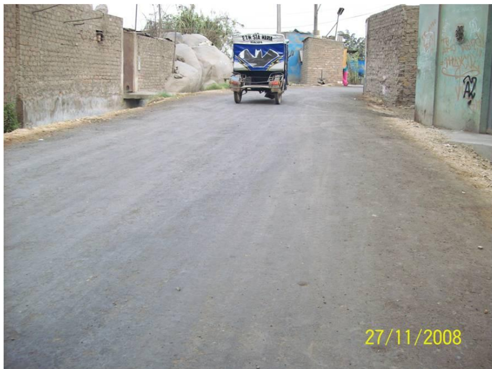
Imagen. 8. Acabado de la superficie de rodadura en Ccarapongo.
