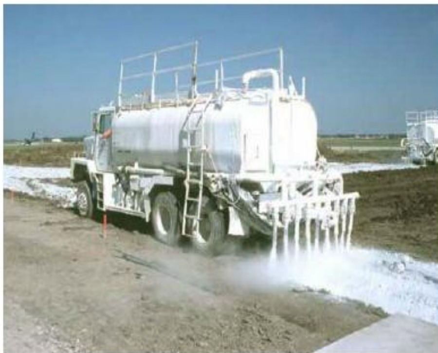
Imagen 5. Aplicación de la Lechada de Cal a la Carretera
