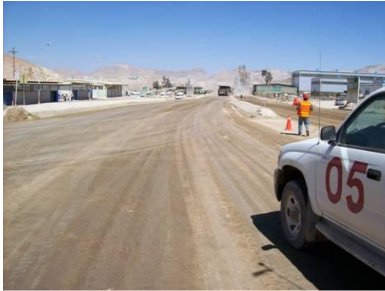
Imagen 9. Tramo después de la aplicación de Roadmag.
