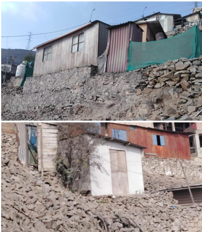
Figura 26. Emplazamiento en pendiente de viviendas en el Asentamiento Humano Nueva Rinconada.
