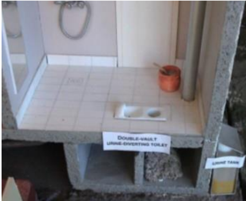
Figura 18. Inodoro en cuclillas que desvía orina con doble cámara de China. Recuperado el 06 de abril del 2020 de https://cgi.tuharburg.de/~awwwweb/wbt/emwater/lessons/lesson_b1/lm_pg_1183.html
