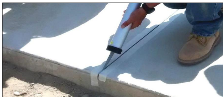
Figura N°17: Sellado de juntas.
