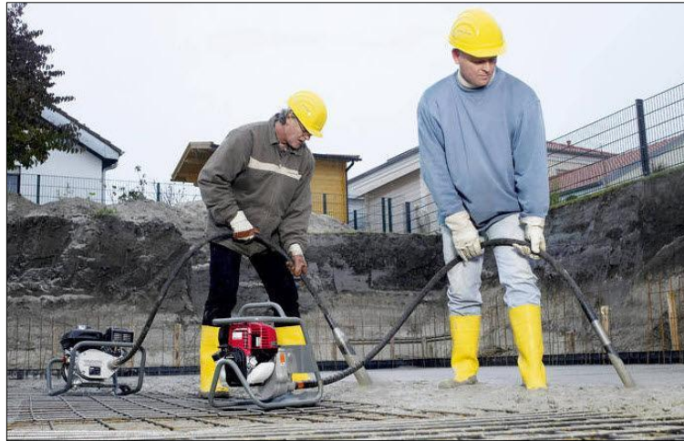
Figura N°2: Vibrador manual de aguja
