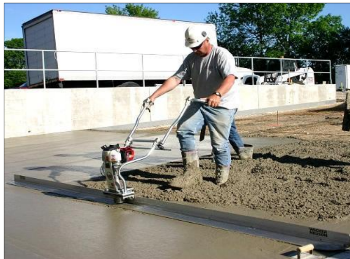
Figura N°1: Regla vibratoria
