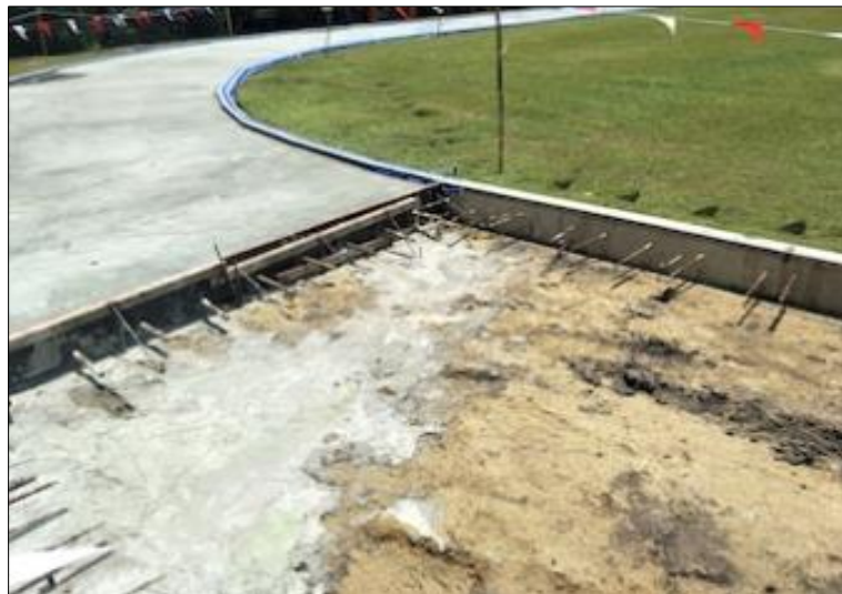
Figura N°13: Juntas de construcción con varillas de refuerzo en encofrado Fuente: (Arkiplus, 2018), Dowels en construcción.
