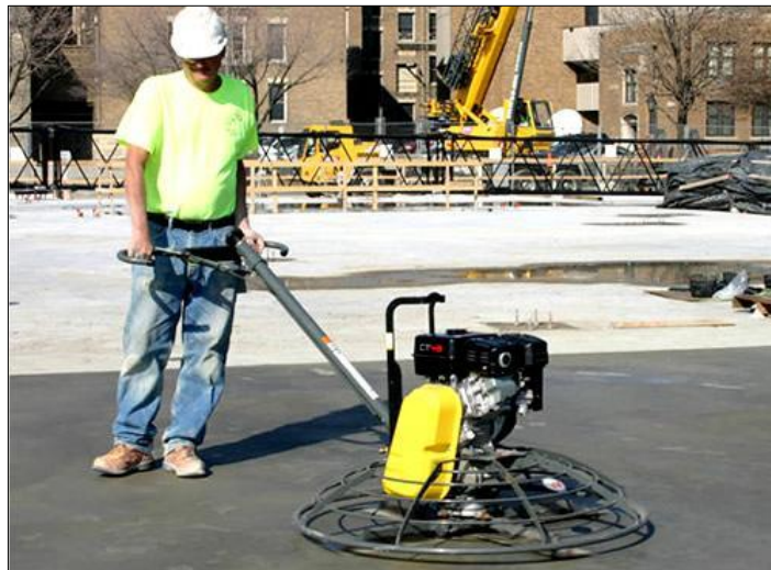
Figura N°5: Alisador o helicóptero
