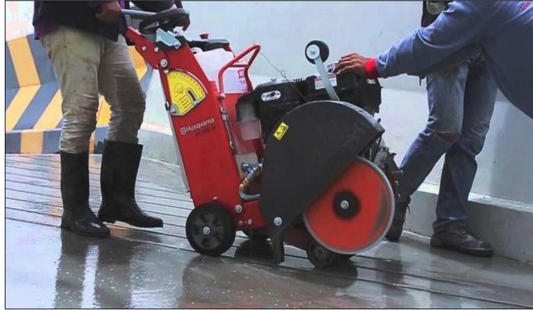
Figura N°3: Cortadora de concreto de ransfer
