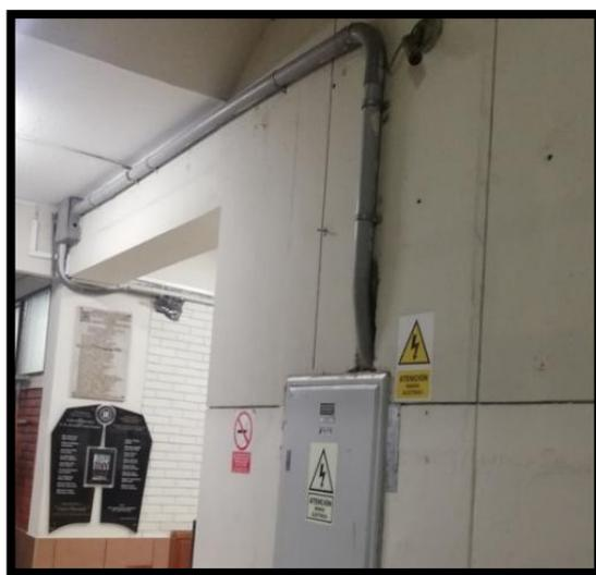
Figura N° 15: Cámara de video vigilancia mal ubicada al lado de un tendido eléctrico.
