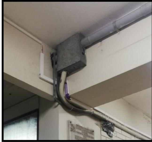
Figura N° 16: Cable de datos pegado a cable eléctrico
