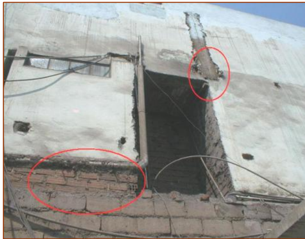
Fig.4-7 Vivienda construída con materiales constructivos sin confinamiento y adosamiento de columna.
