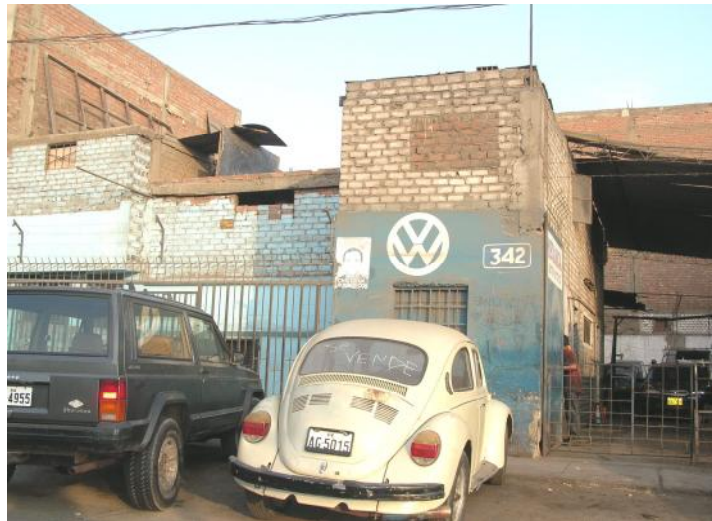
Fig. 7-1 Vivienda del Sector 3 sin diseño estructural ni arquitectónico Fuente: Elaboración Propia
