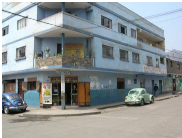
Fig. 5-3 Se observa el tipo de construcción de una vivienda en la Urb. San Pablo Fuente: Elaboración propia
