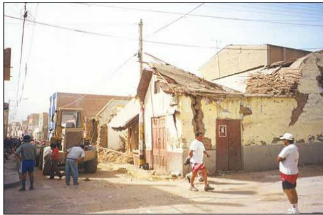
Fig.4-1 Viviendas autoconstruídas destrozadas luego de un sismo Fuente: Cortesía INDECI
