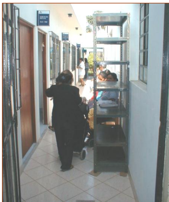
Fig.4-9 Centro de Salud con pasadizo obstruído (ineficiente sistema de evacuación) Fuente: Elaboración propia
