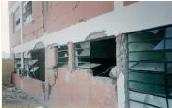
Fig.4-10 Institución Educativa con daños estructurales importantes, Sismo Nazca 1996 Fuente: Cortesía Dr. Julio Kuroiwa H.
