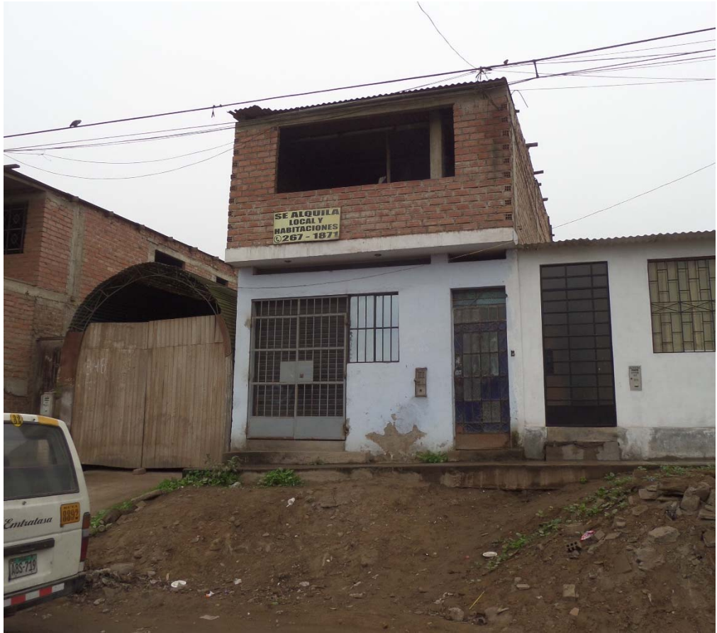
Imagen 20. Alquiler de habitaciones y tienda en primer nivel. Sin ingresos propios a las habitaciones. (Fotografía propia)
