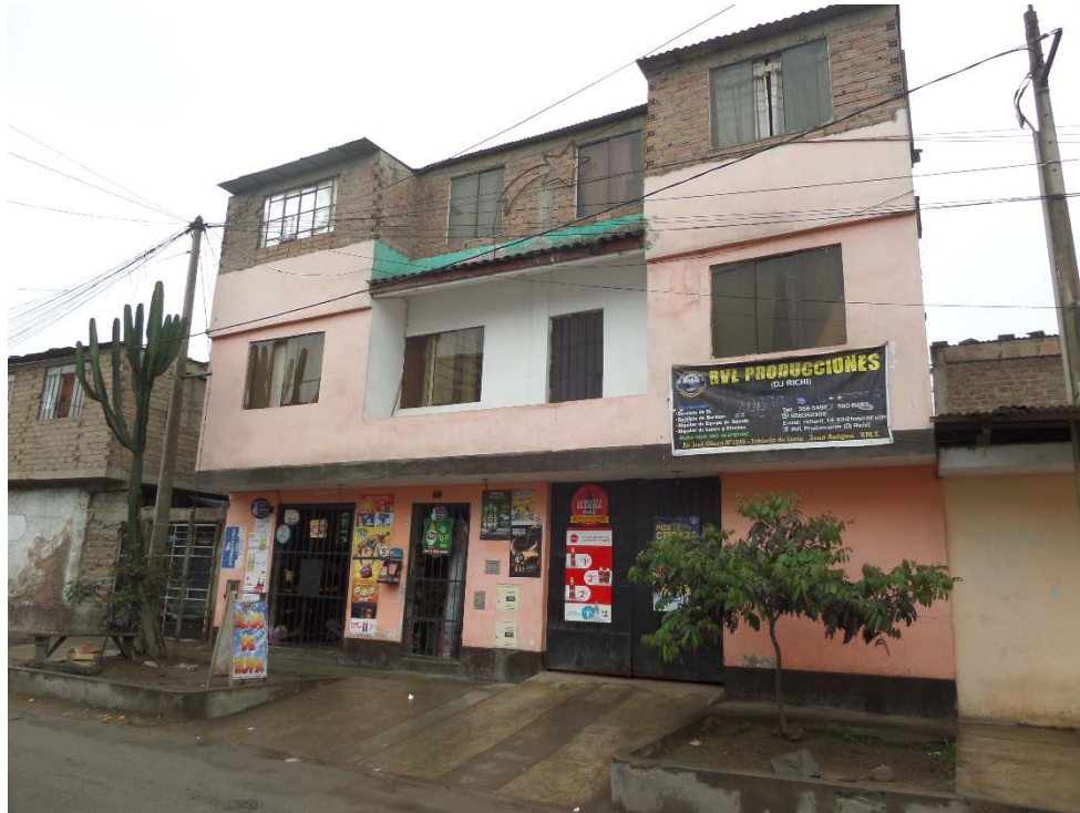
Imagen 23. Fachada de vivienda de 3 pisos. Con dos bodegas y una lavandería en el primer piso y servicios para eventos musicales en su segundo nivel. (Fotografía propia)
