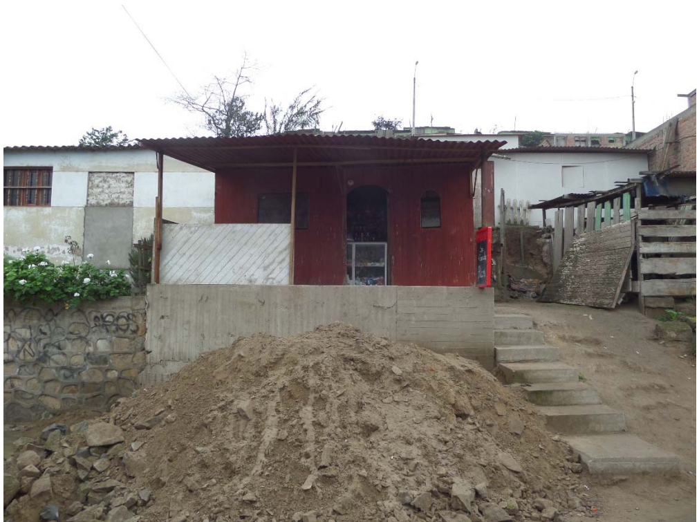
Imagen 18. Vivienda prefabricada con fachada comercial en calle Francisco de Zela. (Fotografía propia)
