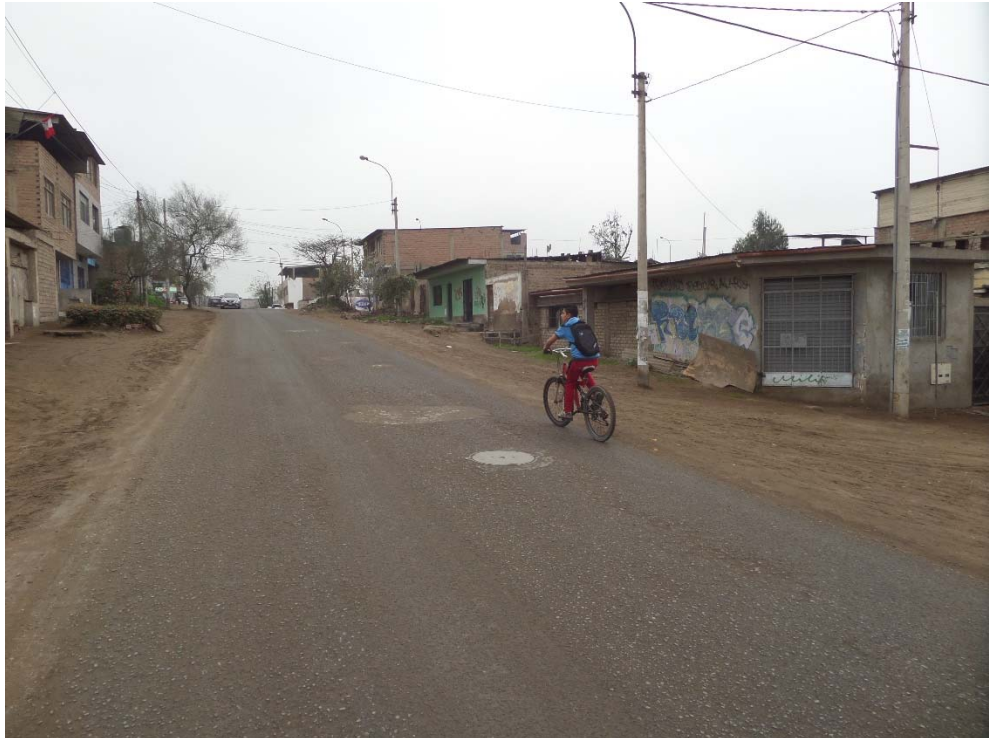
Imagen 48. Jirón Lima, vía asfaltada pero sin veredas. (Fotografía propia)
