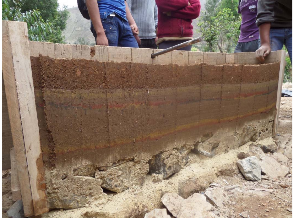
Imagen 8. Muro con técnica de pigmentos. Seminario de Tapial en Tarma (2014).
