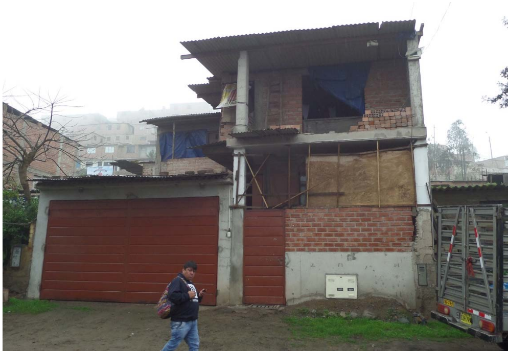
Imagen 15. Cerramientos precarios en niveles superiores, vivienda incompleta pero habitada (Fotografía propia)
