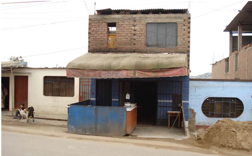
Imagen 13. Ejemplo de vivienda producida por la autoconstrucción con restaurante y cocina afuera de la vivienda invadiendo el retiro municipal. (Fotografía propia)
