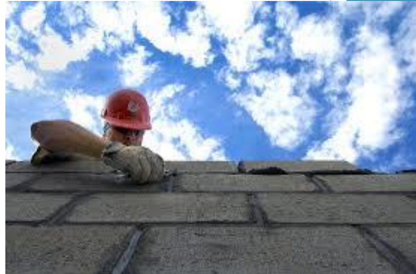
BLOQUES DE CONCRETO CON BLINDAJE DE PLOMO (ÁREA DIAGNOSTICO)
