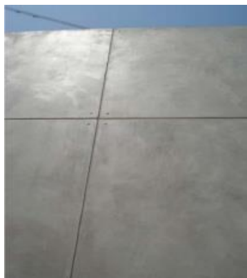
MICROCEMENTO EN FACHADA
