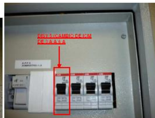
CONEXIONADO DE LA ALIMENTACION -48V DC LIBRE
