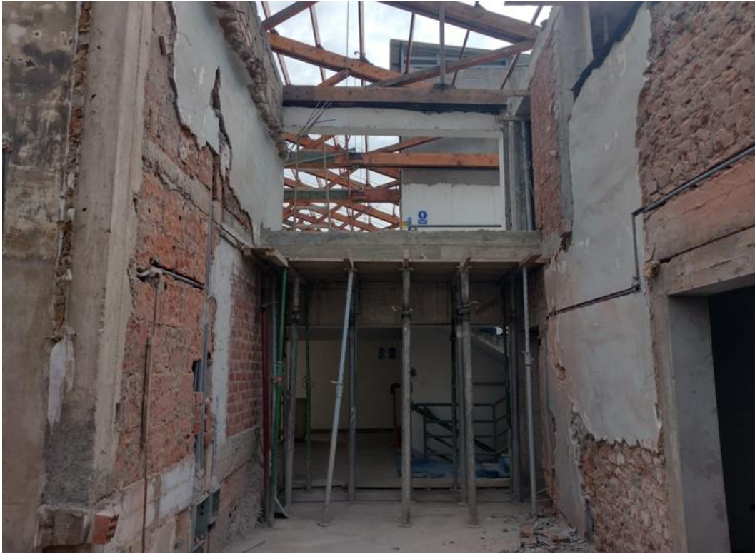
Figura 24 Hall de espera en segundo piso en restauración.
