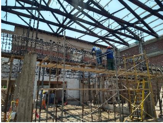
Figura 8 Imagen de inicios de obra con construcción de columnas, placas y vigas.
