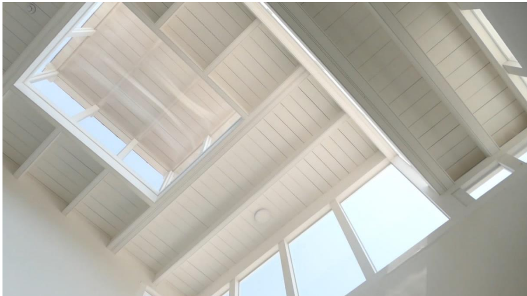
Figura 29 Teatina o Linternas nuevas, con nueva madera, pintura y vidrios laminados.
