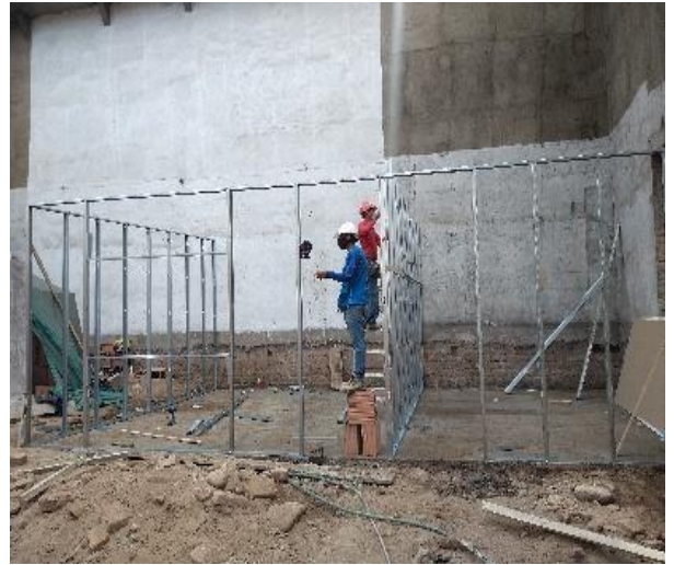
Figura 12 Imagen de parte posterior de la obra donde se construyó el escenario con piso de madera entablado.
