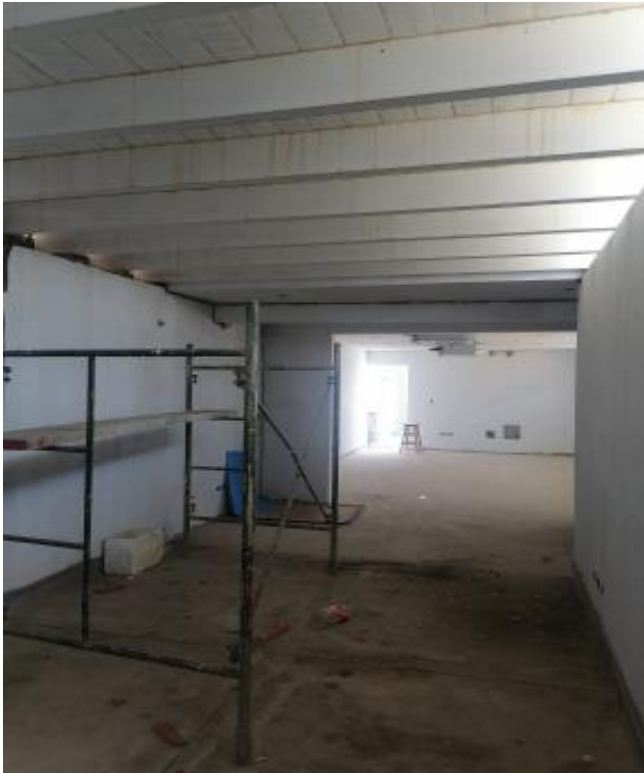
Figura 22 Construcción del cuarto de cómputo.
