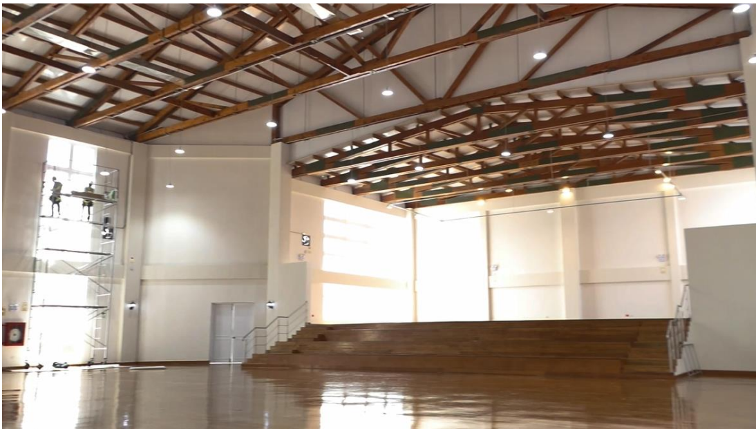
Figura 15 Imagen con las cerchas o tijerales de madera restaurados.
