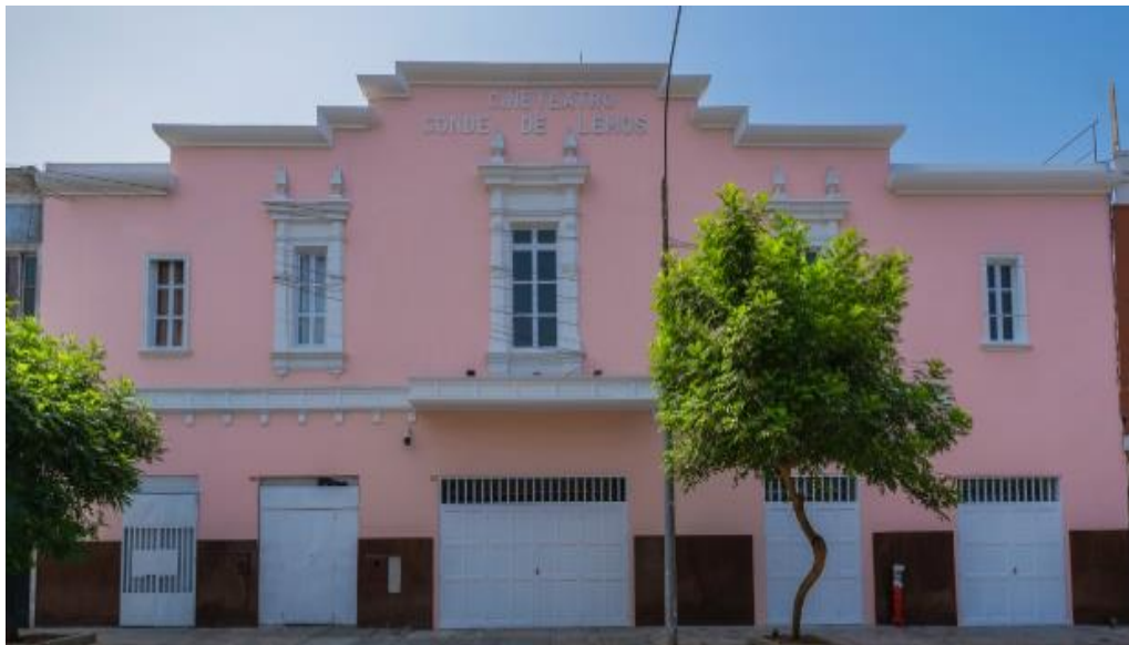
Figura 31 Fachada de la Casa Vecinal Conde De Lemos restaurada, nuevas ventanas, nueva pintura, nuevas puertas.
