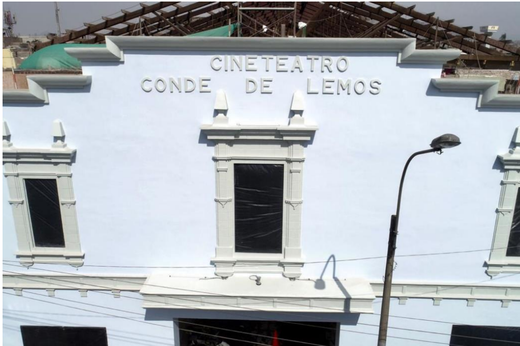
Figura 30 Fachada de la Casa Vecinal N°4 sin restaurar
