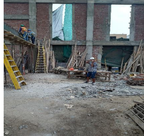
Figura 9 Imagen de encofrado para vaciado de vigas.
