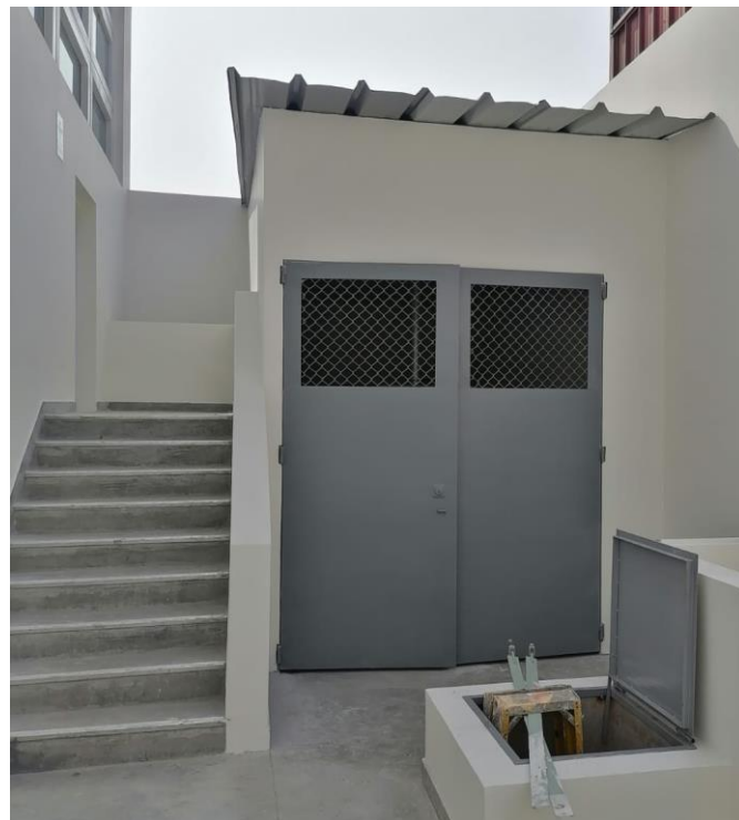
Figura 19 Zona de escalera al escenario y cuarto del generador eléctrico culminados, pintados y entregados a EMILIMA.
