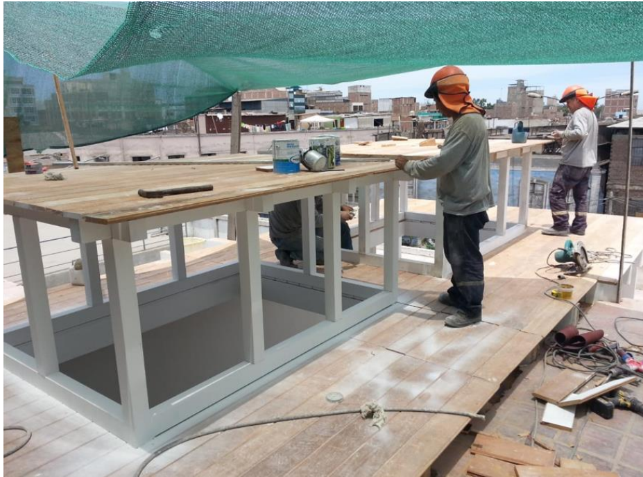
Figura 28 Construcción de Linternas o Teatinas
