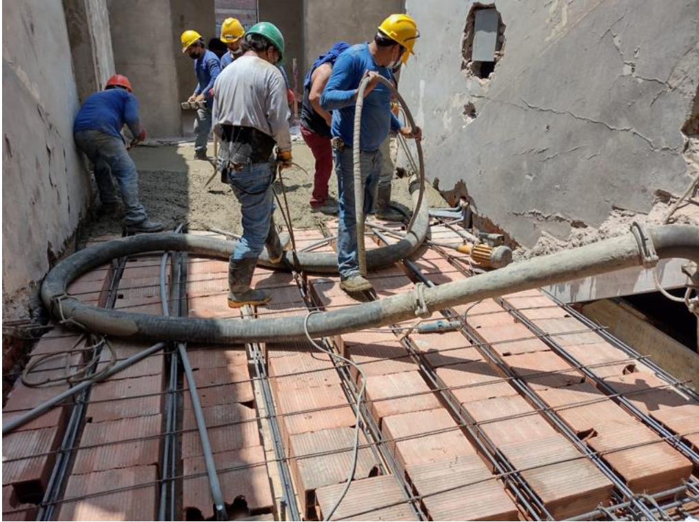
Figura 26 Construcción de losa aligerada para hall de espera.
