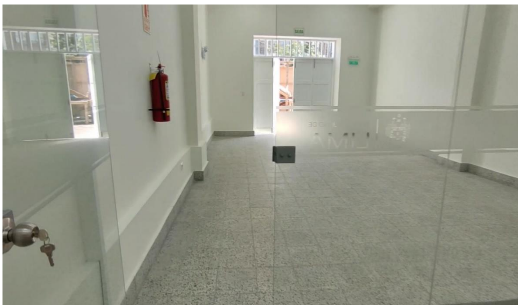
Figura 17 Sala de Reuniones GPV y Sala de Reuniones 1 con mamparas y puertas instaladas y entregadas sin observaciones.
