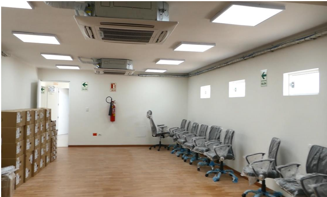
Figura 23 Cuarto de cómputo en el 3er Piso entregado, con aire acondicionado y piso laminado.
