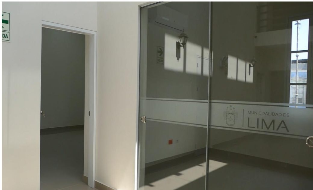
Figura 27 Losa aligerada del hall de espera restaurada y terminada.
