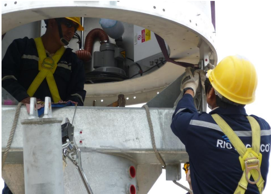
Figura 47: Ajustes finales del Reflector al King Post
