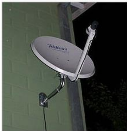
Figura 14: Antena Offset
