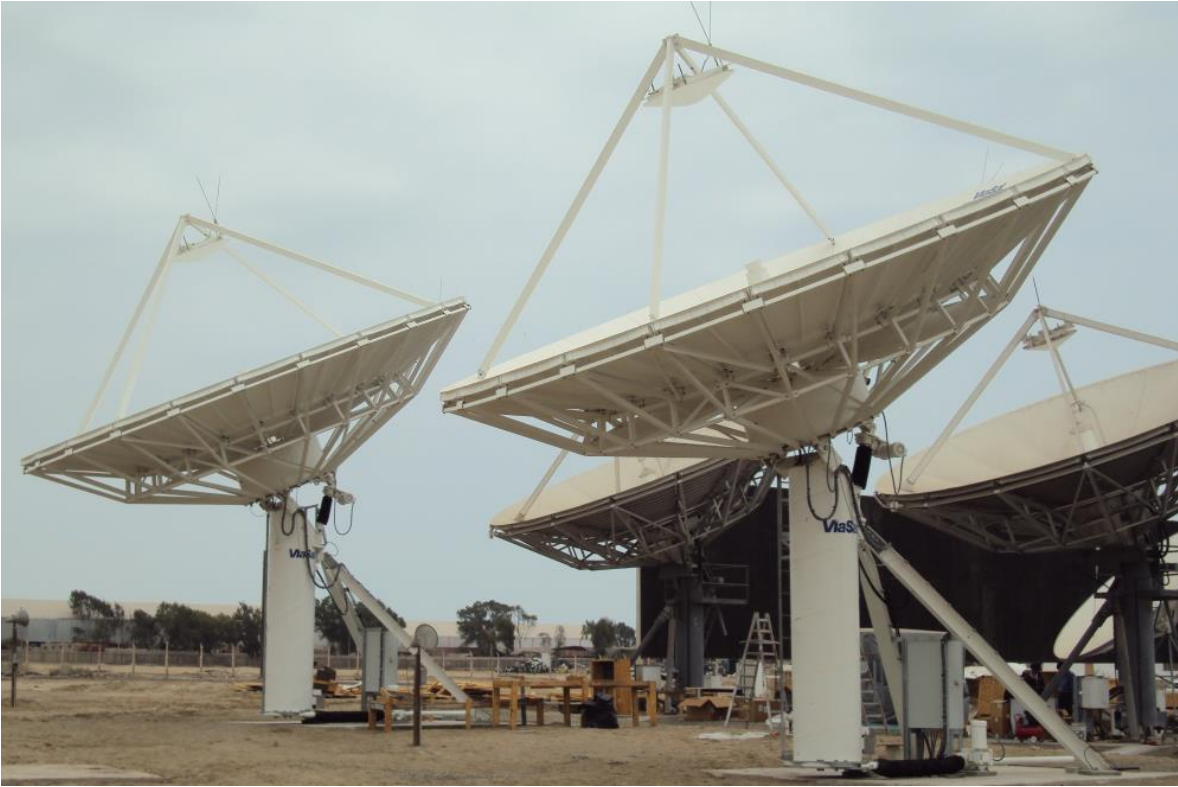
Figura 53: Patio de antenas con vista principal de la antena del proyecto
