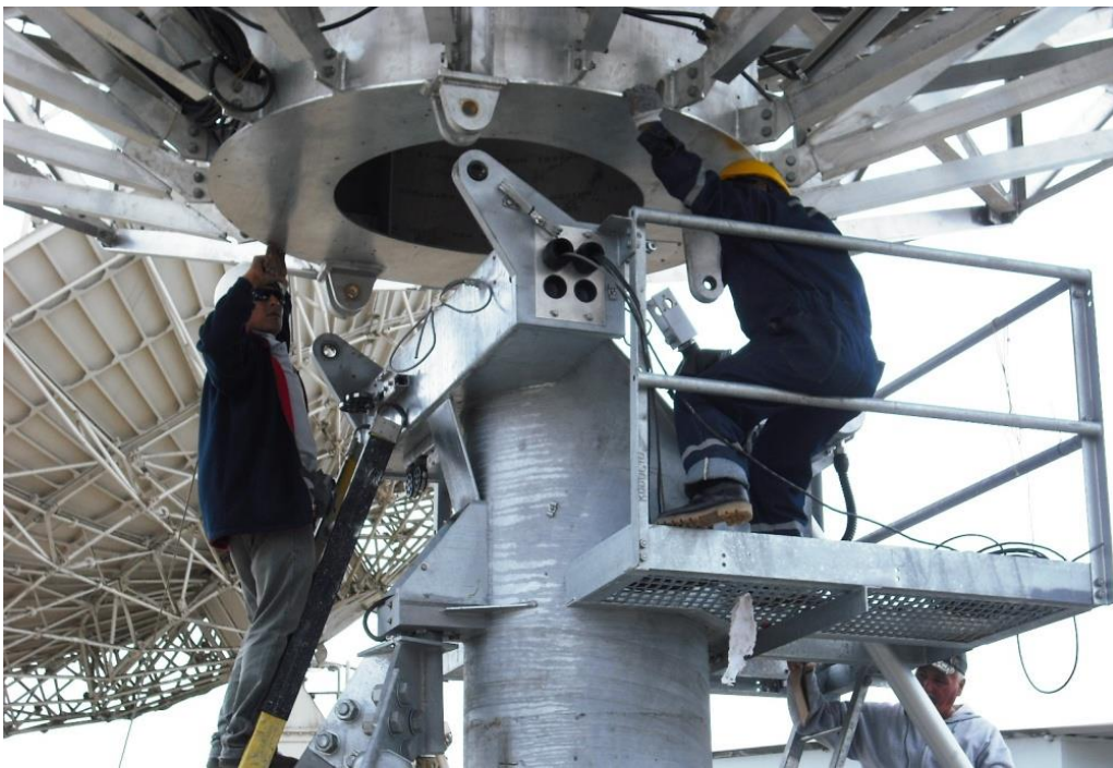
Figura 46: Continuación de ensamblaje de Reflector al King Post
