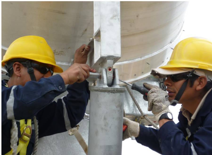
Figura 40: Fijación del Pivot
