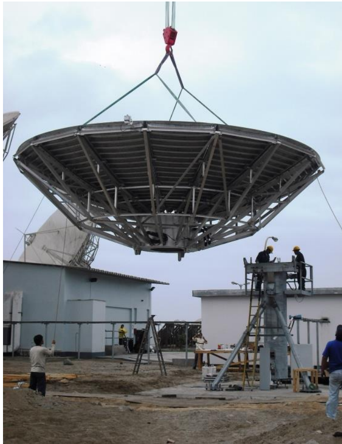
Figura 44: Traslado del Reflector Parabólico hacia el King Post
