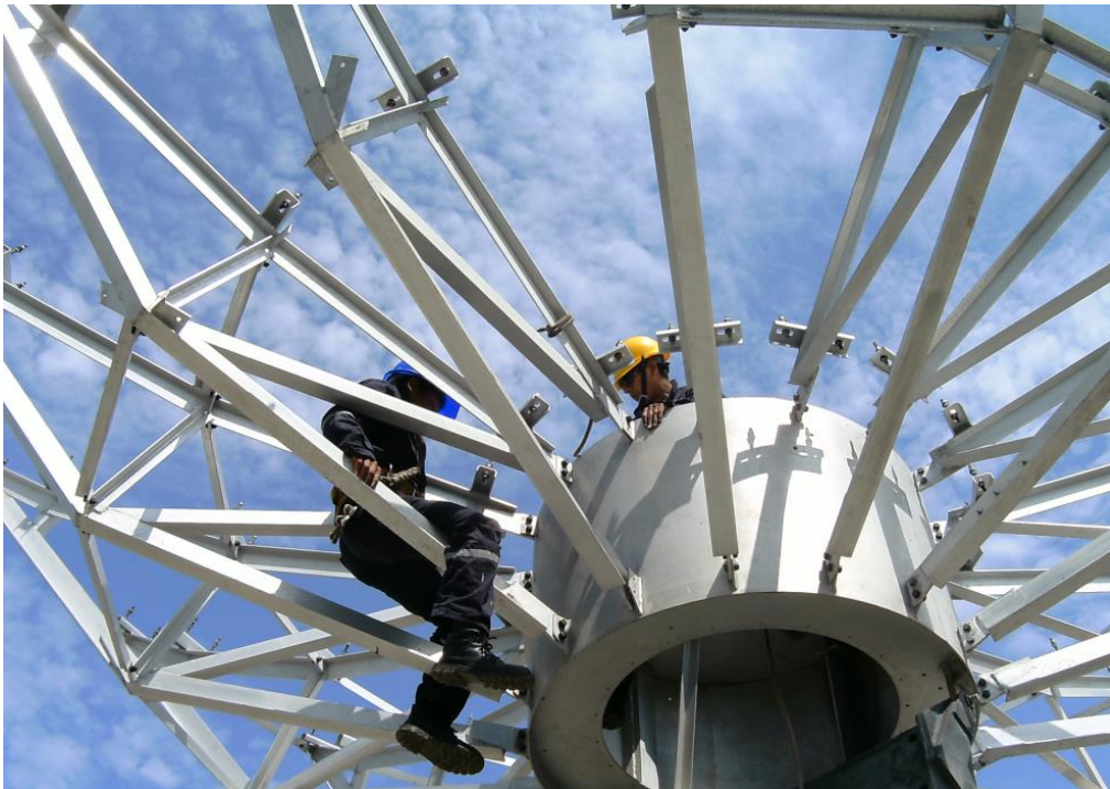
Figura 37: Ensamblaje de la Superficie Reflectora
