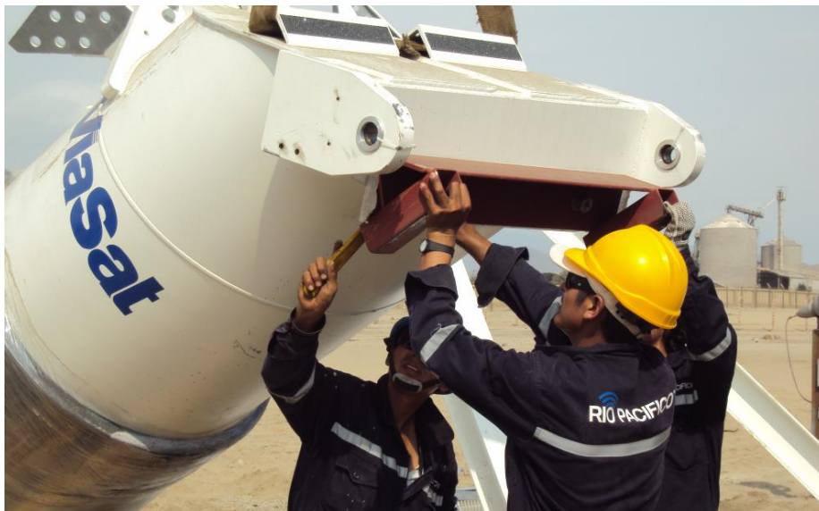
Figura 39: Izamiento del soporte del King Post
