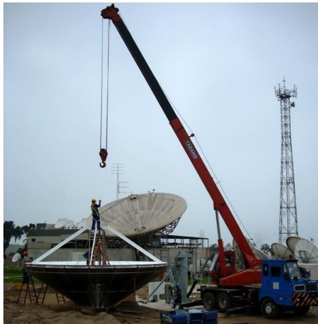
Figura 43: Inicio de izamiento del Reflector Parabólico
