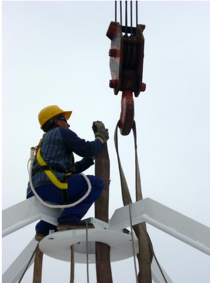
Figura 52: Retiro de estrobos de grúa luego de ensamble
