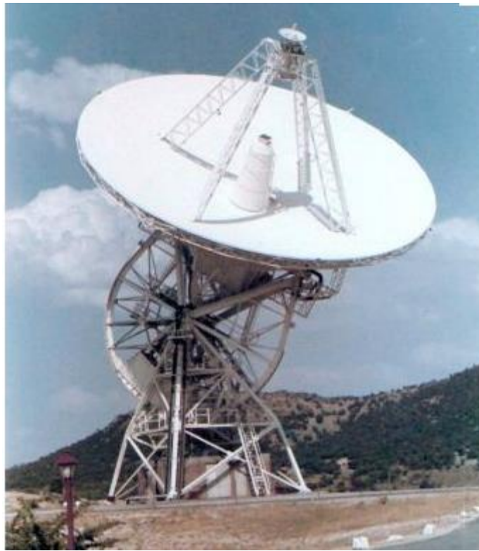
Figura 15 Antena Cassegrain
