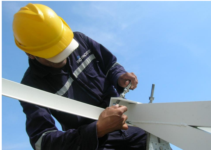
Figura 42: Ensamblaje del Soporte de Antena
