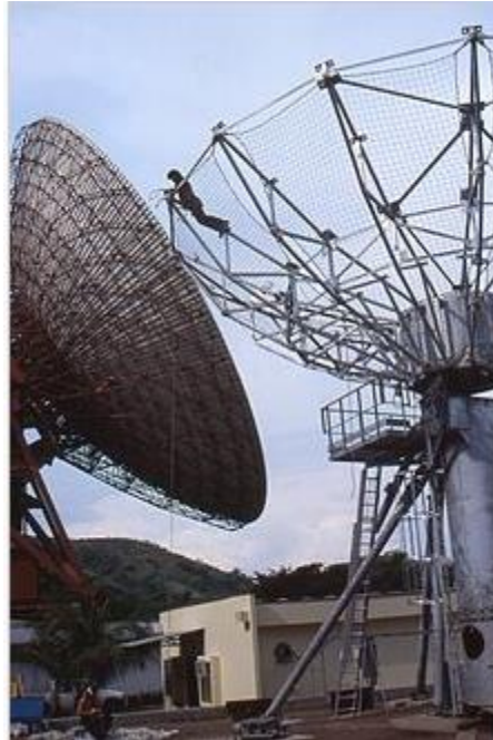
Figura 13: Antena Foco Centrado o Primario
