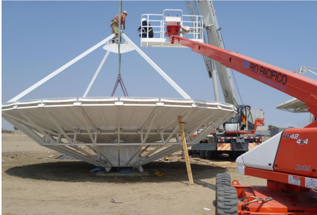
Figura 38: Armado de la Superficie Reflectorora
