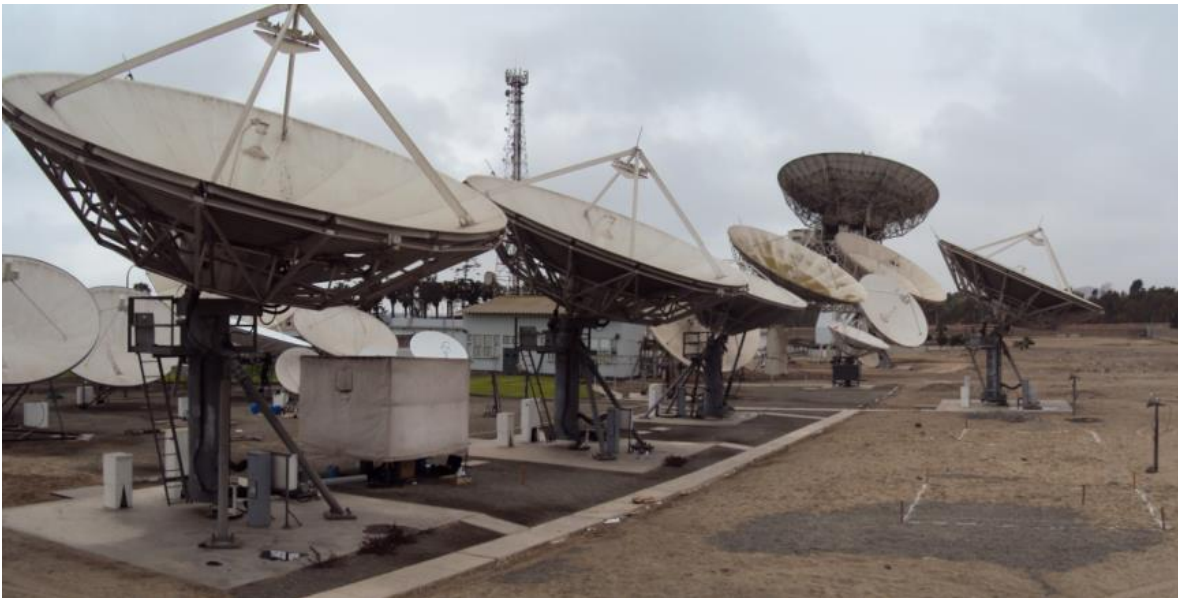
Figura 54: Patio de antenas 2
