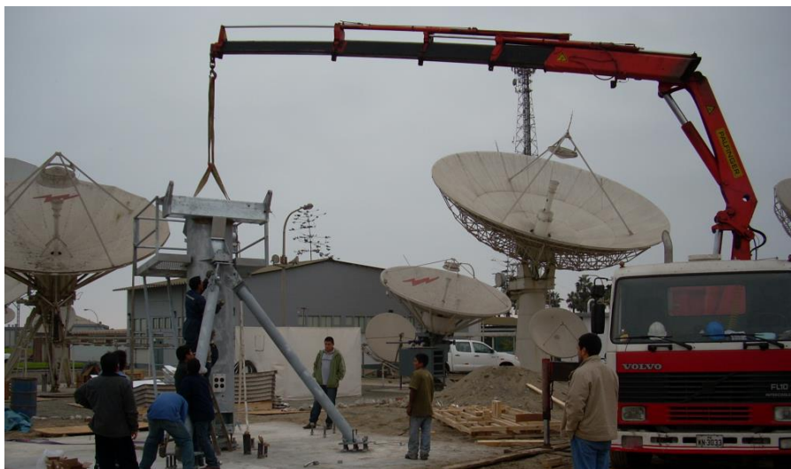
Figura 41: Montaje del King Post por medio de grúa
