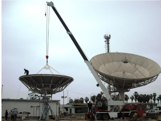
Figura 45: Ensamblaje de Reflector y King Post
