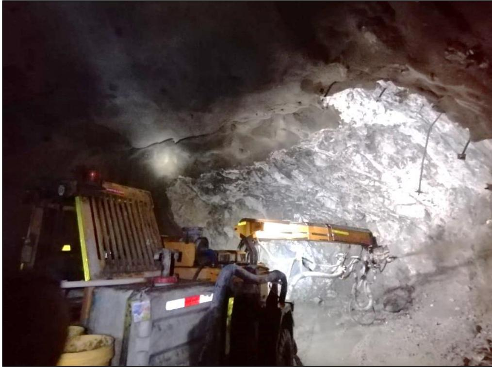
Figura 08 Sostenimiento con shotcrete – Caída de Shotcrete TJ 953E xVTN522S. Empresa.
