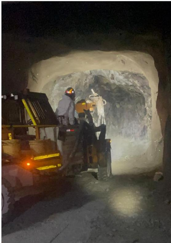
Figura 04 Aplicación de Shotcrete en minería Subterránea. Empresa
