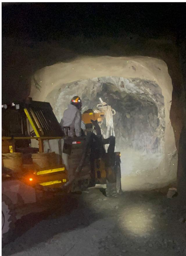
Figura 31 Sostenimiento con shotcrete usando equipo aplicador ROBOT SPM4210 PUTZMEISTER- Unidad Minera BATEAS
