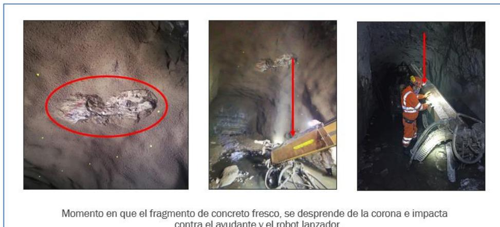
Figura 39 Evento por desprendimiento de shotcrete fresco. CAM 474W Nv. 18. U.M Bateas
