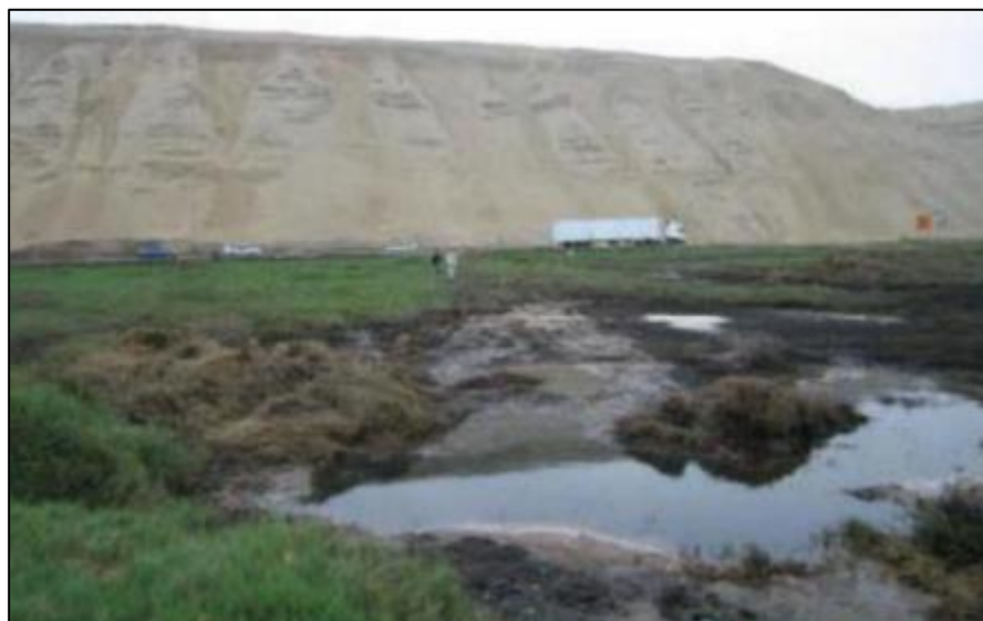
Figura 7. Falla del talud.
