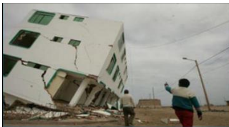
Figura 2. Derrumbe de una casa de tres pisos en Lomo de Corvina.
