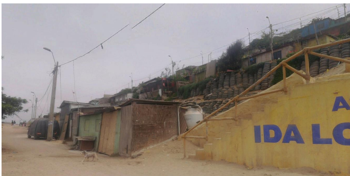
Figura 26. Casas prefabricadas sector Lomo de Corvina. Fuente. Google Earth.
