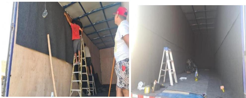
Figura N°32. Forrado de camión con tapices
