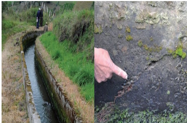
Figura N 3 :Inspección del canal de regadío
