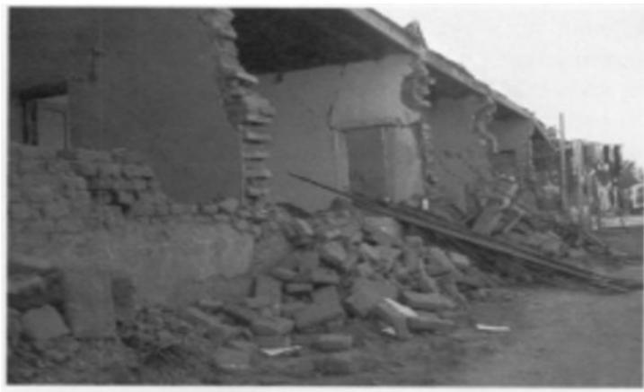
Figura N° 3 Colapso de la fachada al quedar libre en voladizo
