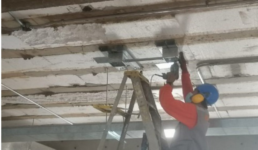
Figura 9. Instalación punto de Data Fuente: Elaboración propia
