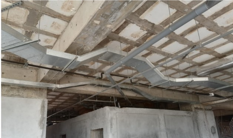
Figura 3. Instalación de bandejas portacables
