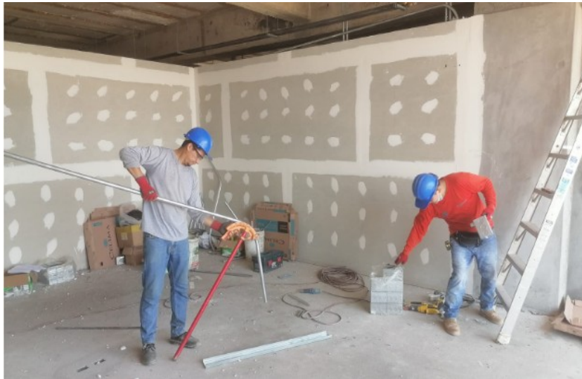
Figura 2. Instalación de data Fuente: Elaboración propia
