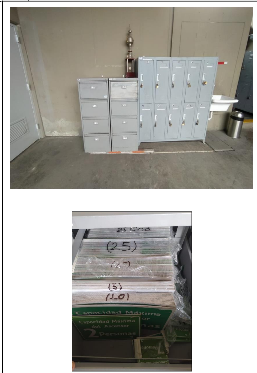
Figura 30. Cajonera “Almacén E” de señaléticas en el Área Técnica de la Estación Angamos.
