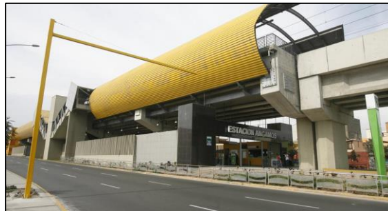
Figura 7. Instalaciones de la Estación Angamos de la Línea 1 del Metro de Lima
