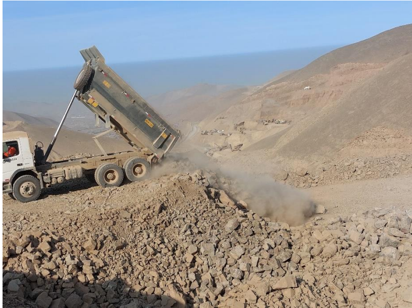
Figura N 13: Formación de banquetas con el material extraído Fuente: Elaboración Propia.
