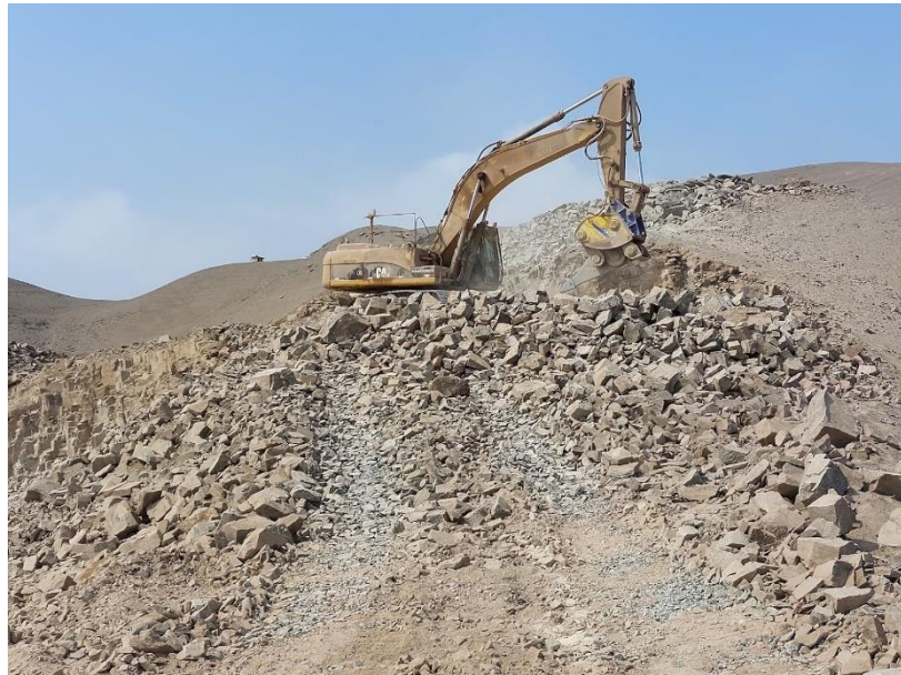
Figura N 3: Extracción con Ripper Fuente: Elaboración propia.
