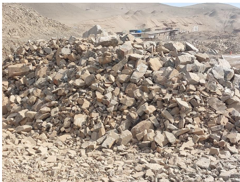
Figura N 16: Acopio de Quarry Run homogeneizado Fuente: Elaboración Propia.
