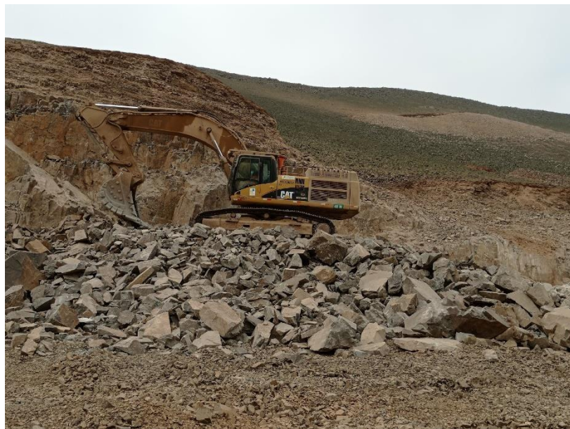
Figura N 2: Extracción con excavadora Fuente: Elaboración propia.
