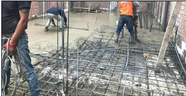
*Figura N° 36:* Losa de concreto reforzada en obra
