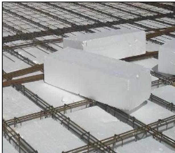
Figura N° 38: El uso de poliestireno en losas
