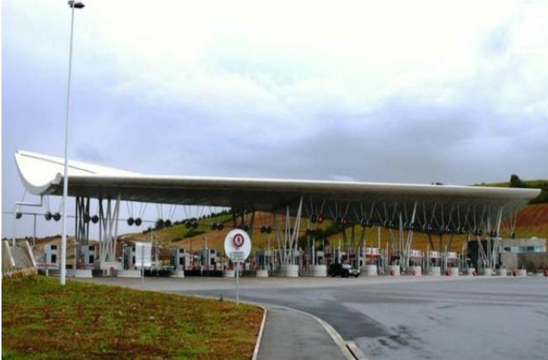
Figura N° 12: Millau Viaduct toll gate, Paris (2004). Fuente: Base internacional y galería de estructuras.
