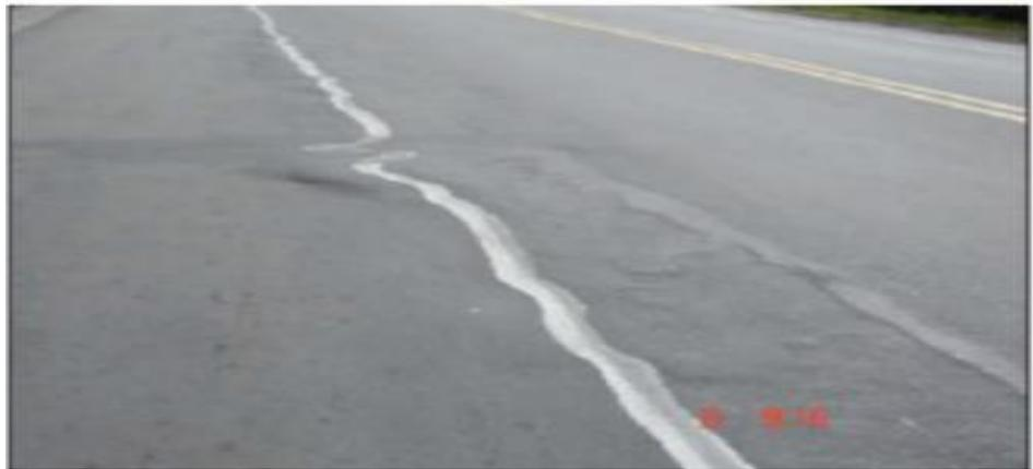
*Figura 41.* Ondulación del pavimento asfáltico.
