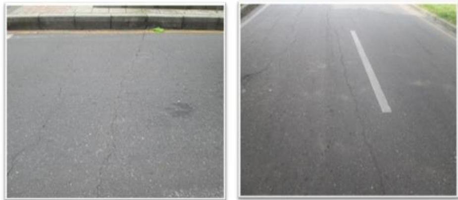
*Figura 39.* Fisuración longitudinal y transversal.
