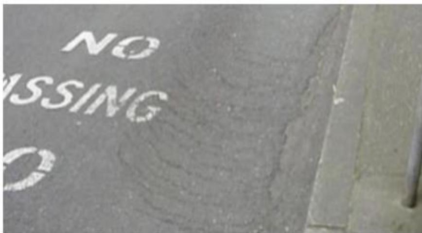
*Figura 11.* Fisuras parabólicas o por deslizamiento
