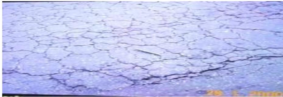
*Figura 37.* Fisura por contracción térmica de un pavimento asfáltico.
