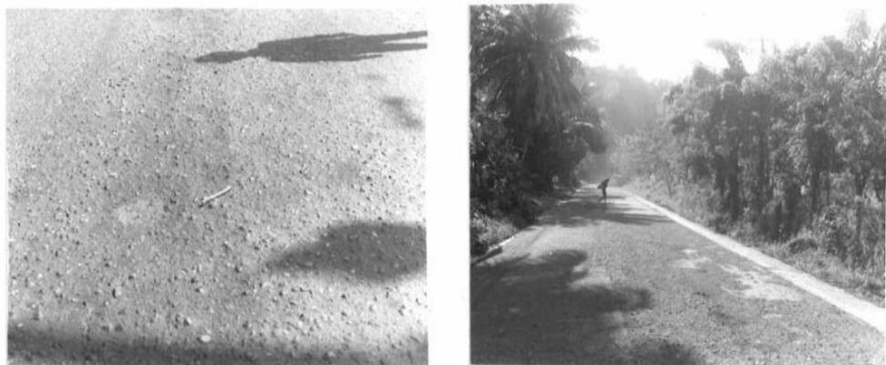
*Figura 44.* Desprendimiento con severidad alta.
