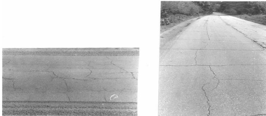
*Figura 43.* Fisura en bloque debido a la variación de temperatura.
