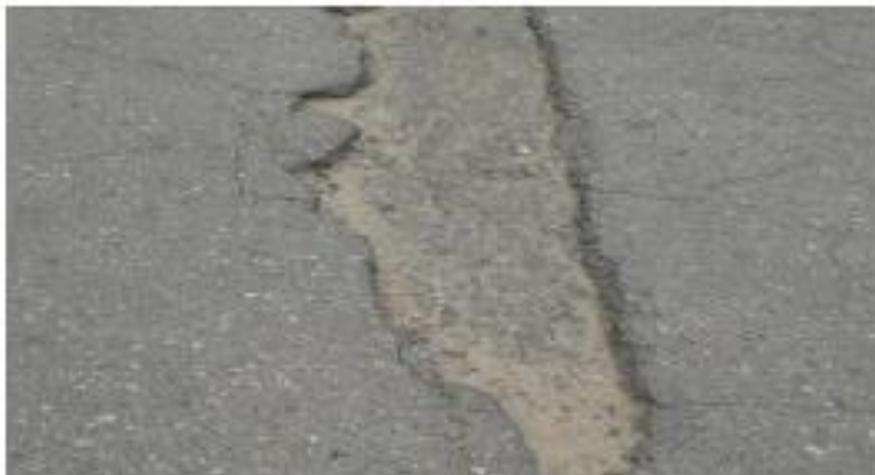
*Figura 21.* Desprendimiento y descaramiento del pavimento
