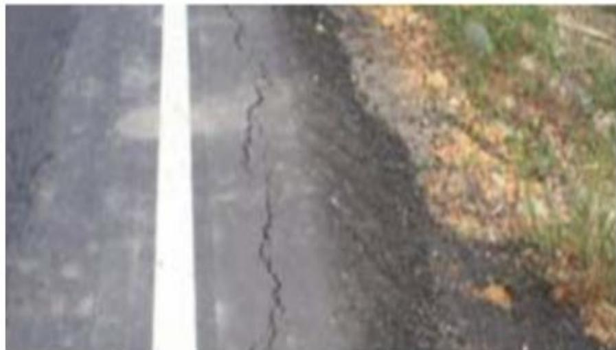
Figura 9. Agrietamiento de borde
