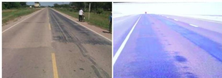
*Figura 38.* Exudación del asfalto
