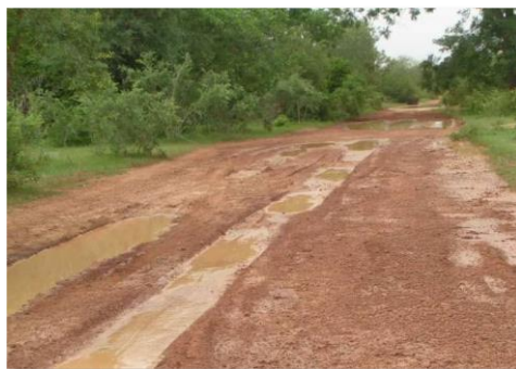
Figura N°4: Ahuellamiento
