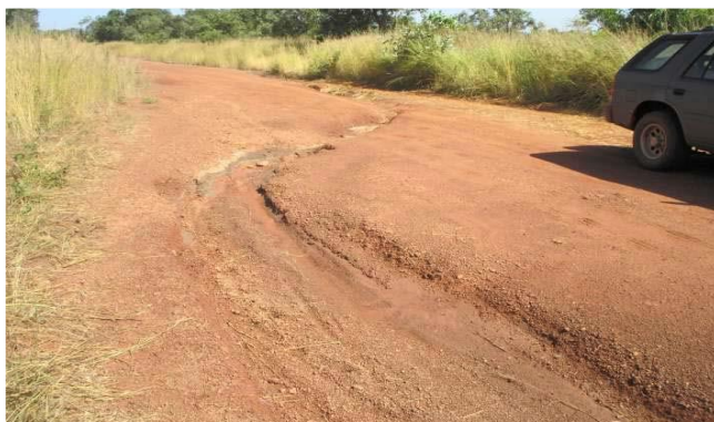
Figura N°11: Gravedad 3 surco Transversal y Longitudinal
