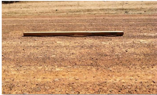
Figura N°8: Ondulación gravedad 1
