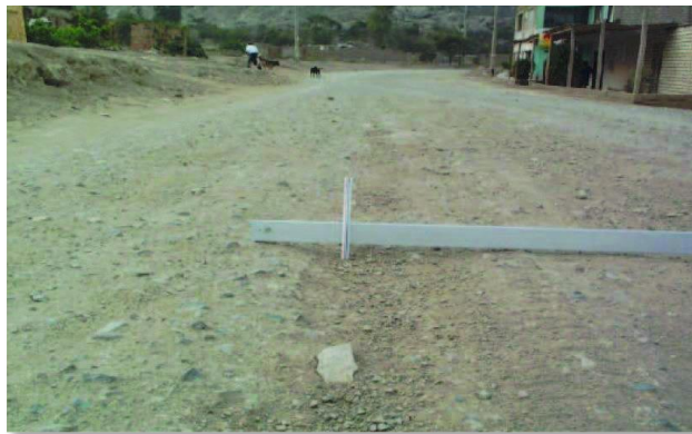
Figura N°21: Hundimientos sensibles al usuario, pero < 5 cm
