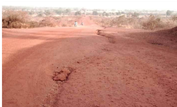
Figura N°12: Gravedad 3 surco longitudinal
