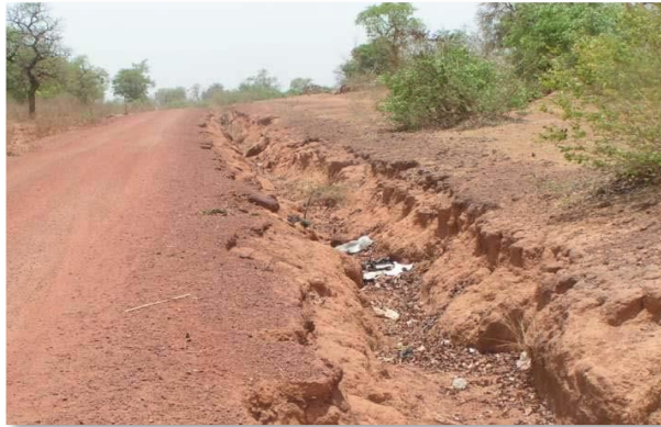
Figura N°16: Erosión longitudinal
