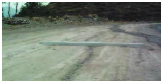
Figura N°24: Gravedad 1: sensible al usuario, pero < 5 cm
