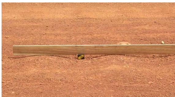
Figura N°10: Ondulación gravedad 3
