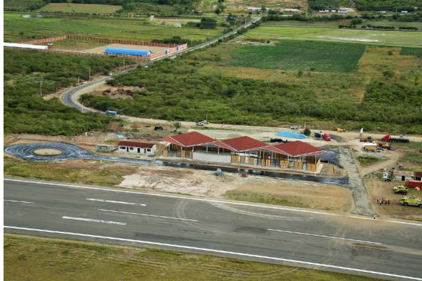
Figura N° 08. Vista aérea del Aeropuerto de Jaen
