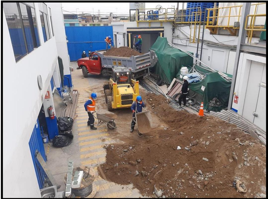
Figura N° 25: Eliminación de Material Excedente en obra
