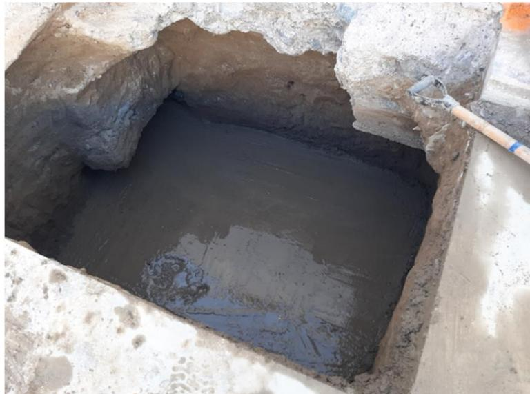
Figura N° 28:Vertido de Concreto para el Solado
