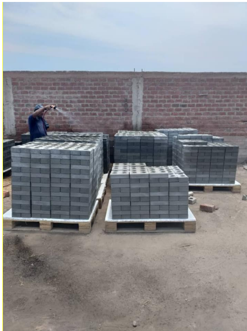
Figura N° 56. Curado del ecoladrillo
