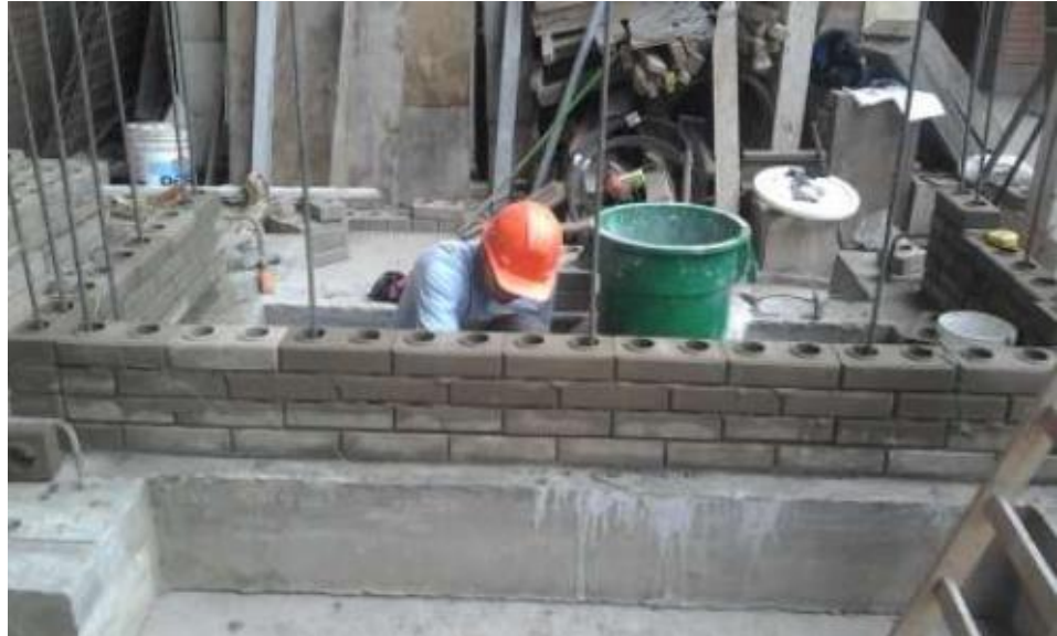
Figura N° 13. Asentado de las primeras hiladas de ladrillo
