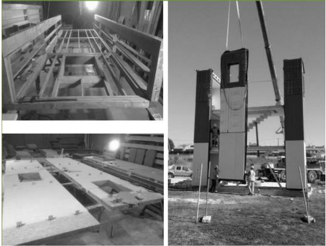
Figura N° 14. Sistema constructivo modular CA2D
