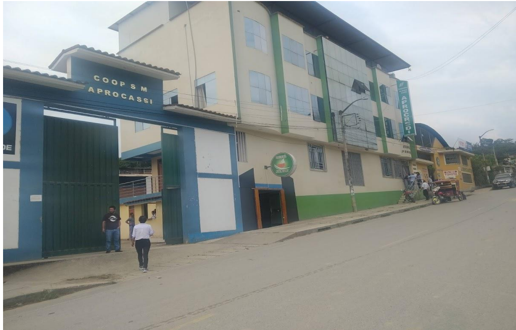
Infraestructura principal de la Cooperativa APROCASSI
