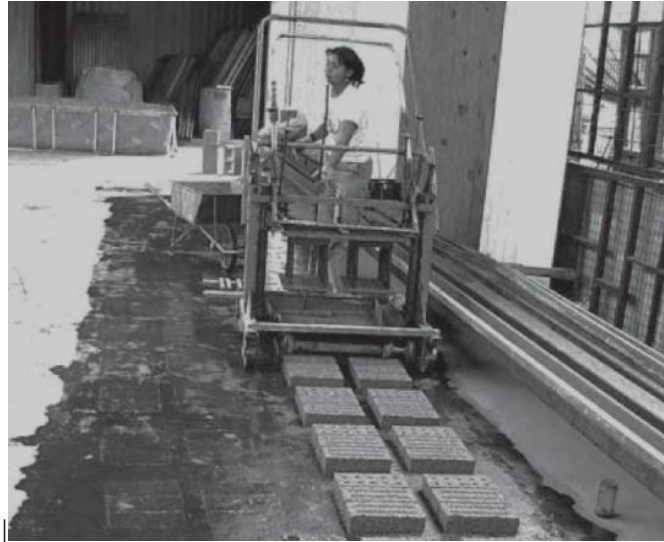
Figura 12 : Proceso de compactación de los ladrillos PET
