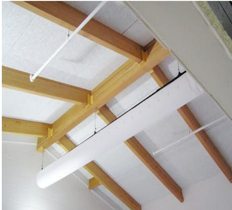
Figura 30 : Aislación térmica con poliestireno expandido
