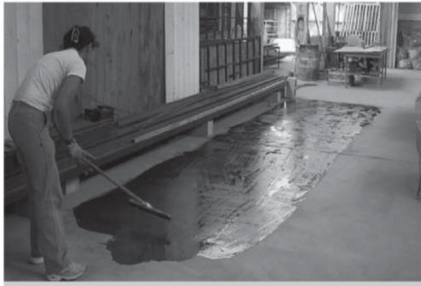
Figura 13 : Lubricación del Piso para evitar adherencia de los ladrillos
