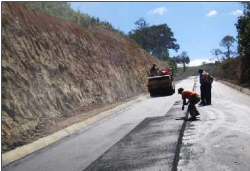
Figura 16 : Fotografía de Compactación de la Mezcla Asfáltica
