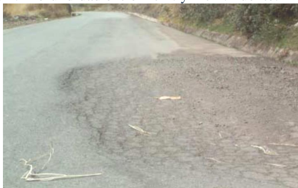
Figura 15. Gravedad 3: Profundidad \geq 4 cm. Fuente: MTC (2016)
