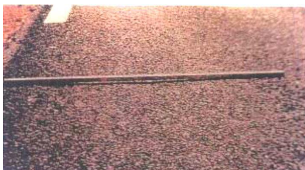
Figura 11. Gravedad 1: Profundidad sensible al usuario ( >0.5 cm) pero <2 cm. Fuente: MTC (2016)
