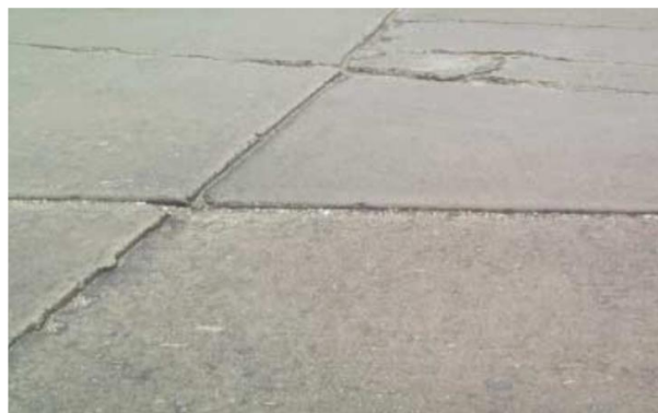
Figura 32. Gravedad 2: Resulta en una reducción significativa de la velocidad. Fuente: MTC (2016)
