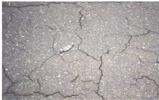
Figura 6. Gravedad 2: Malla mediana (entre 0.30 mm y 0.5 mm) sin o con material suelto. Fuente: MTC (2016).
