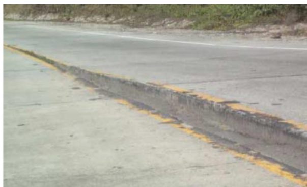
Figura 33. Gravedad 3: Resulta en una reducción drástica de la velocidad. Fuente: MTC (2016)
