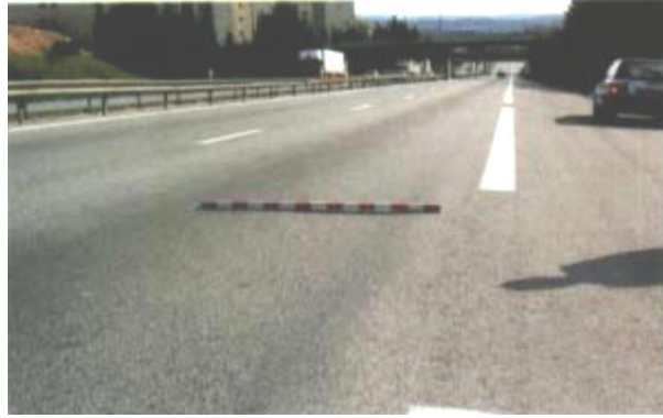
Figura 16. Gravedad 1: Profundidad sensible al usuario ( >0.5 cm) pero < 1 cm. Se observa una marcación del trazado de las ruedas. Fuente: MTC (2016)
