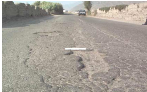
Figura 25. Gravedad 2: Diámetro entre 0.2 y 0.5 m. Fuente: MTC (2016)
