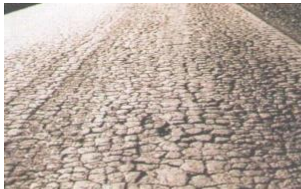
Figura 7. Gravedad 3: Malla pequeña (<0.3 m) sin o con material suelto. Fuente: MTC (2016).
