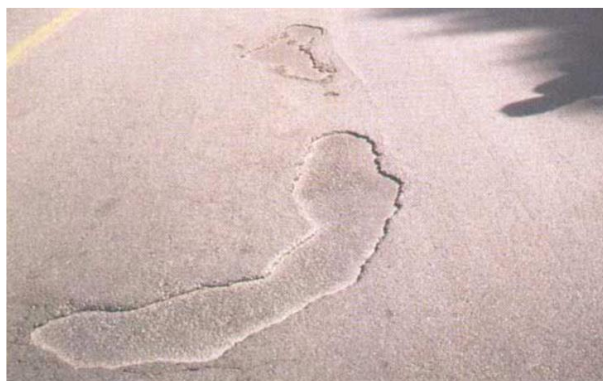
Figura 22. Gravedad 1: Puntual sin aparición de la base granular (concreto asfáltico). Fuente: MTC (2016)
