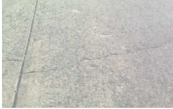
Figura 41. Gravedad 1: Finas. Fuente: MTC (2016)
