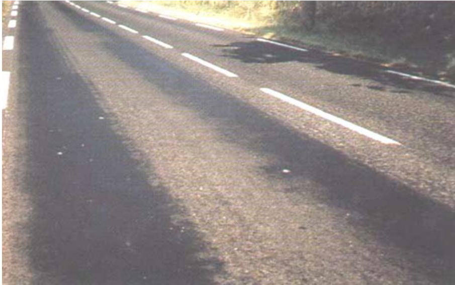
Figura 29. Gravedad 3: Continúa con superficie viscosa. Fuente: MTC (2016)
