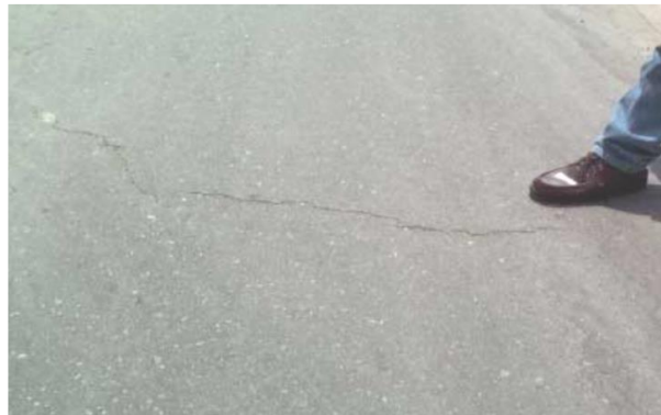
Figura 27. Gravedad 1: Finas. Fuente: MTC (2016)
