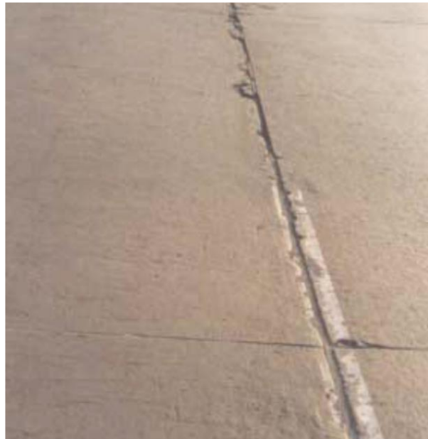
Figura 31. Gravedad 1: Sensible al usuario sin reducción de la velocidad. Fuente: MTC (2016)
