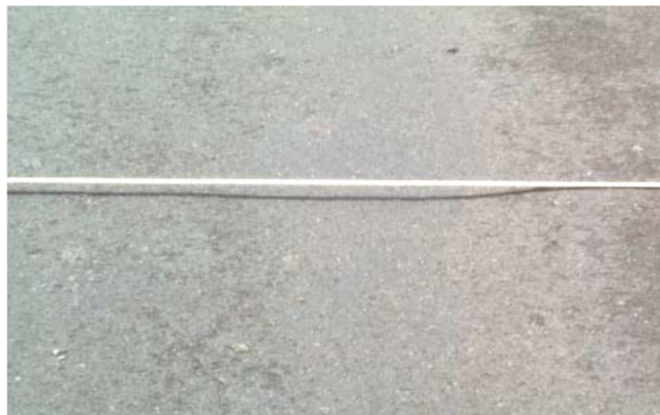
Figura 14. Gravedad 2: Profundidad entre 2 cm. y 4 cm. Fuente: MTC (2016)
