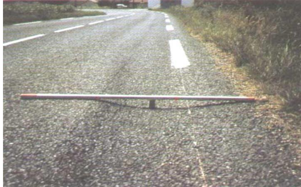
Figura 13. Profundidad \geq 4 cm. Fuente: MTC (2016).
