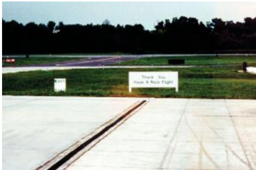
Figura N°21 Whitetopping en el Aeropuerto Spirit of St. Louis (1994)
