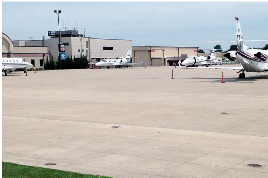
Figura N°22 Whitetopping en el Aeropuerto Spirit of St. Louis (2016)
