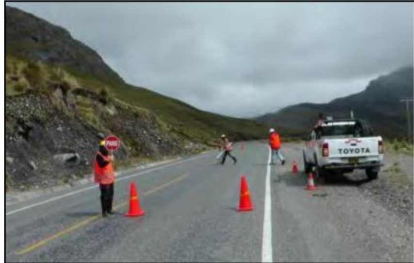
Figura N°28: Levantamiento de fallas 1 en la carpeta de rodadura Fuente: Adaptado de Thenoux (2010)
