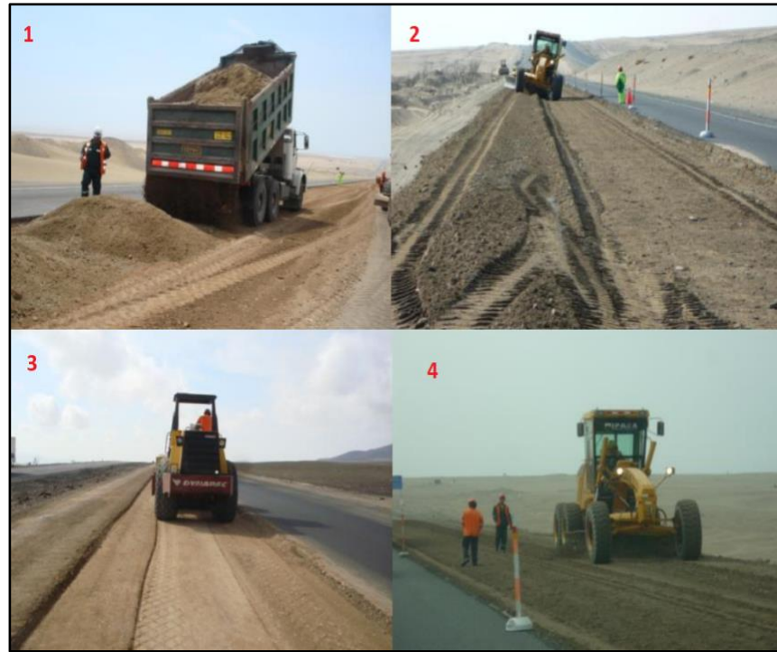
Figura N°42: (1) Colocación, (2) Esparcido (3) Compactación y (4) Perfilado final de material adicionado para la base granular Fuente: Adaptado de Thenoux (2010)
