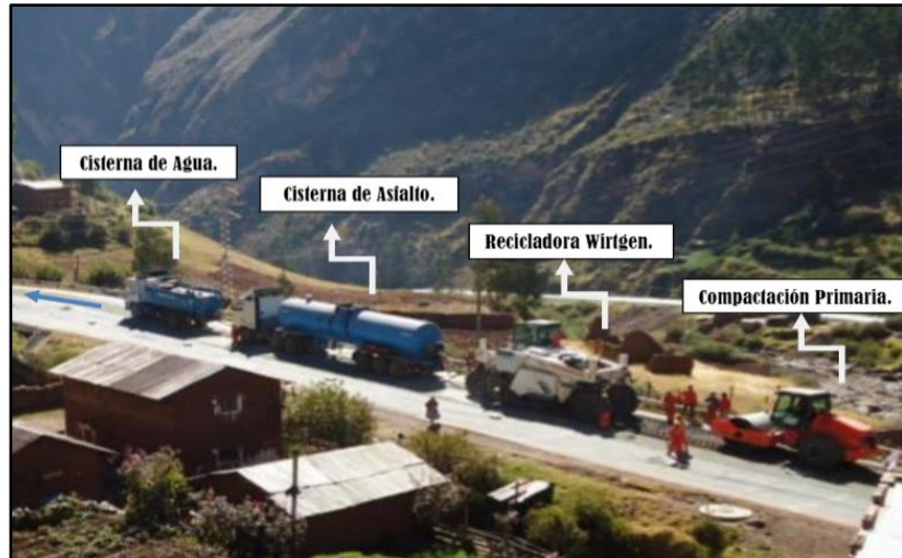
Figura N°43: Equipos para aplicación de la tecnología Fuente: Adaptado de Galvis (2012)
