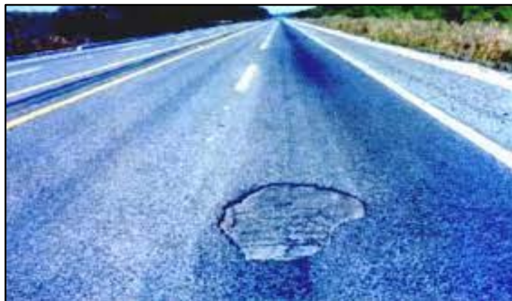
Figura N°6: Segregaciones en pavimentos asfálticos Fuente: Adaptado de Padilla (2004)
