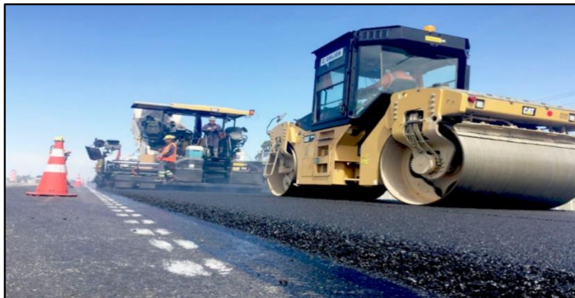
Figura N°45: Compactación primaria Fuente: Adaptado de Thenoux (2010)
