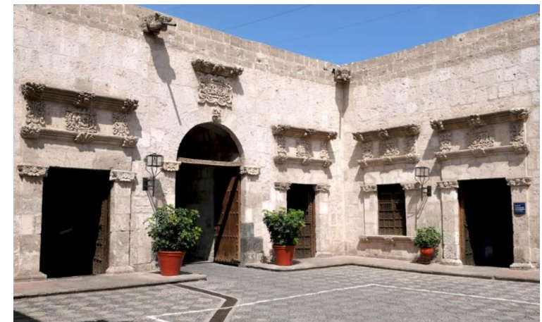
Imagen 40: Casa Tristán del Pozo
