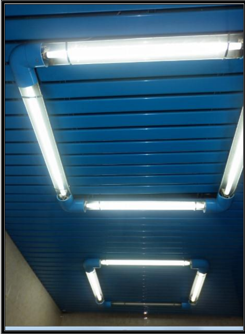
Fotografía N°6: Baño de la Facultad de Ingeniería de la URP
