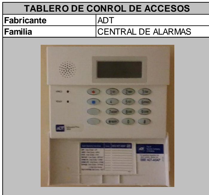
Figura N°17: Elaboración Propia. Tablero de control de accesos
