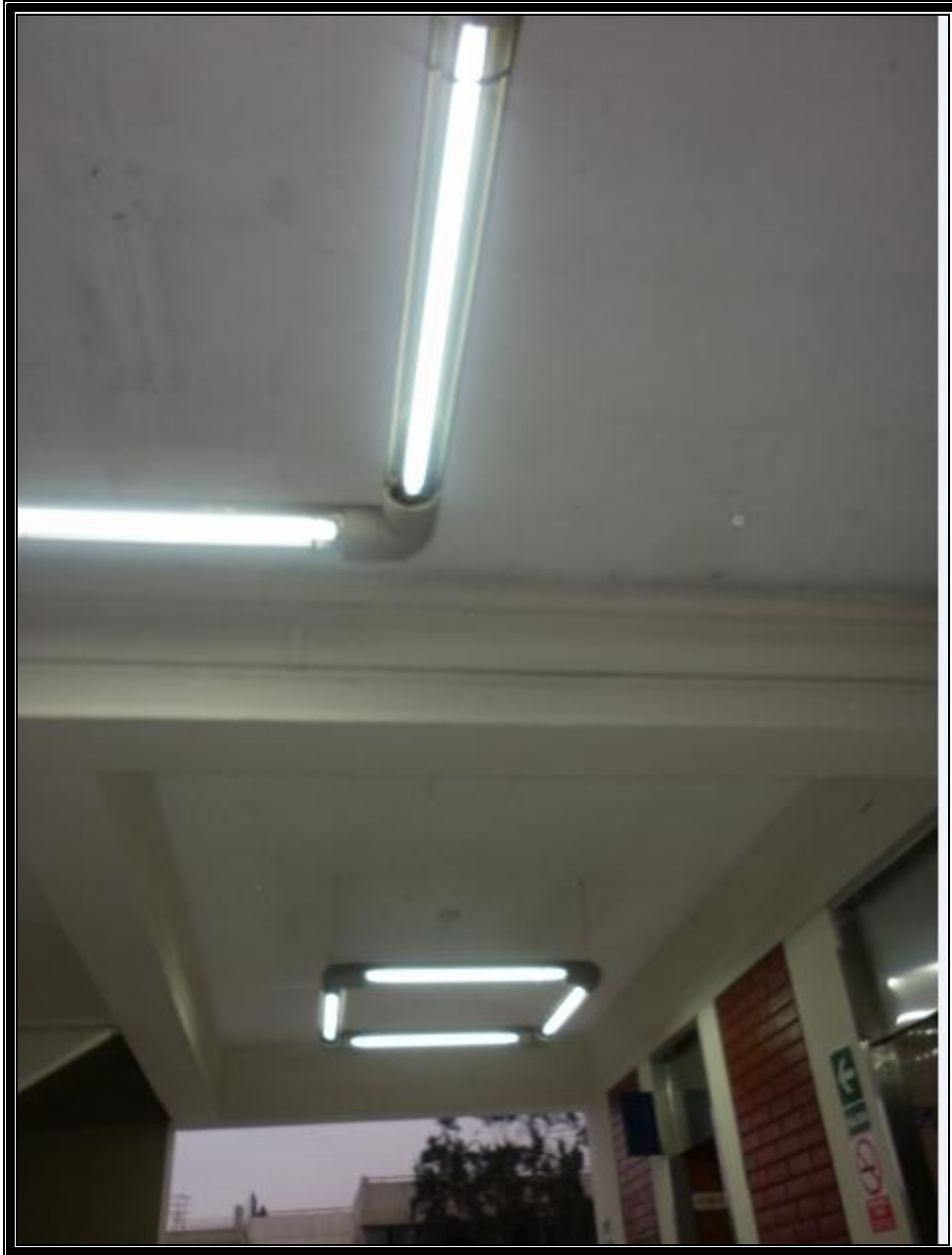
Fotografía N°2: Pasadizos de la Facultad de Ingeniería de la URP
