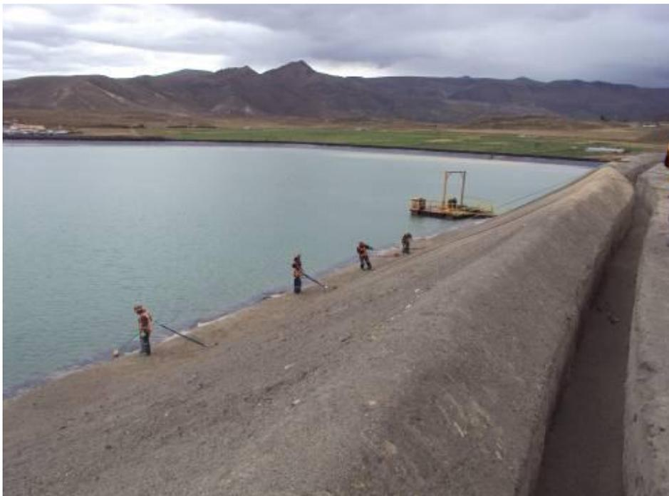
Fotografía 29. Evaluación de soldadura por cuña en talud de zona Este
