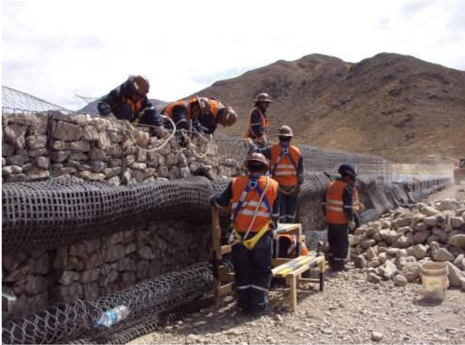
Fotografía 26: Colocación y llenado de gaviones en la zona suroeste, luego se continuara con la conformación de relleno en la parte posterior.
