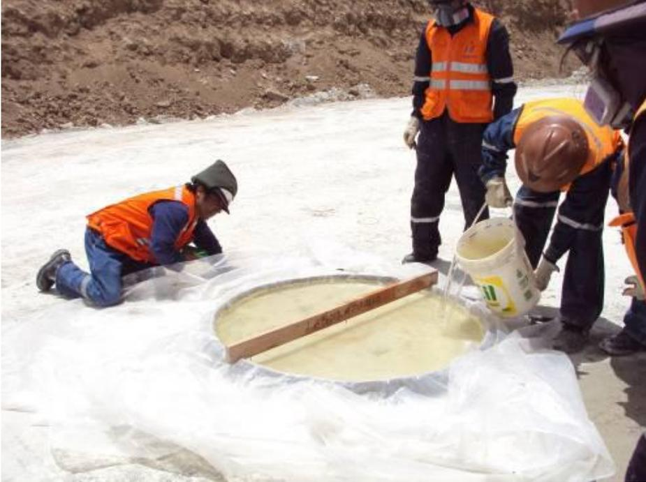
Fotografía 8: Batido y conformación de la cuarta capa de material de baja permeabilidad en la zona suroeste.
