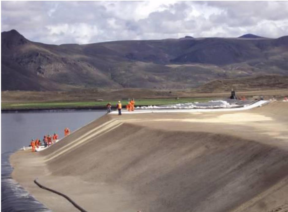
Fotografía 37: Despliegue de geomembrana en la zona Sureste. Se puede notar la cantidad de sacos de lastre utilizados para asegurar el área.
