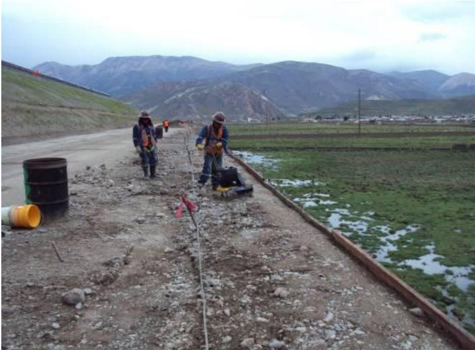
Fotografía 46: Ejecución de parche en geomembrana secundaria instalada en la zona suroeste.
