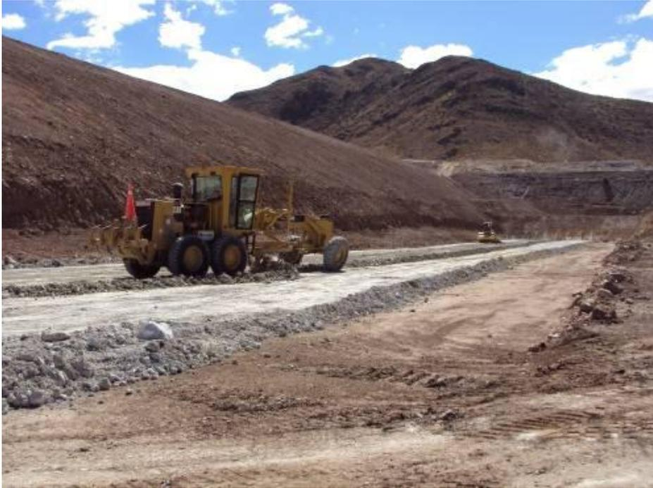
Fotografía 5: Verificación de los controles de compactación en el material de desmonte de mina. Se aprecia las 4 capas colocadas a la fecha (8 de octubre del 2009)
