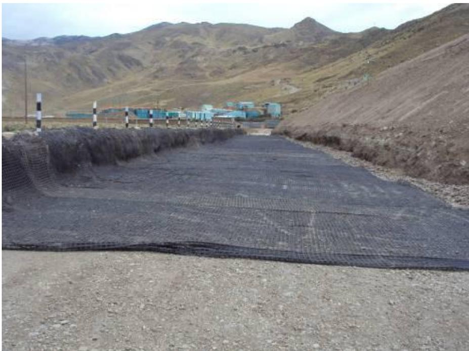
Fotografía 17: Vista panorámica de la zona Norte, se puede observar la colocación de la geomalla de refuerzo de este a oeste
