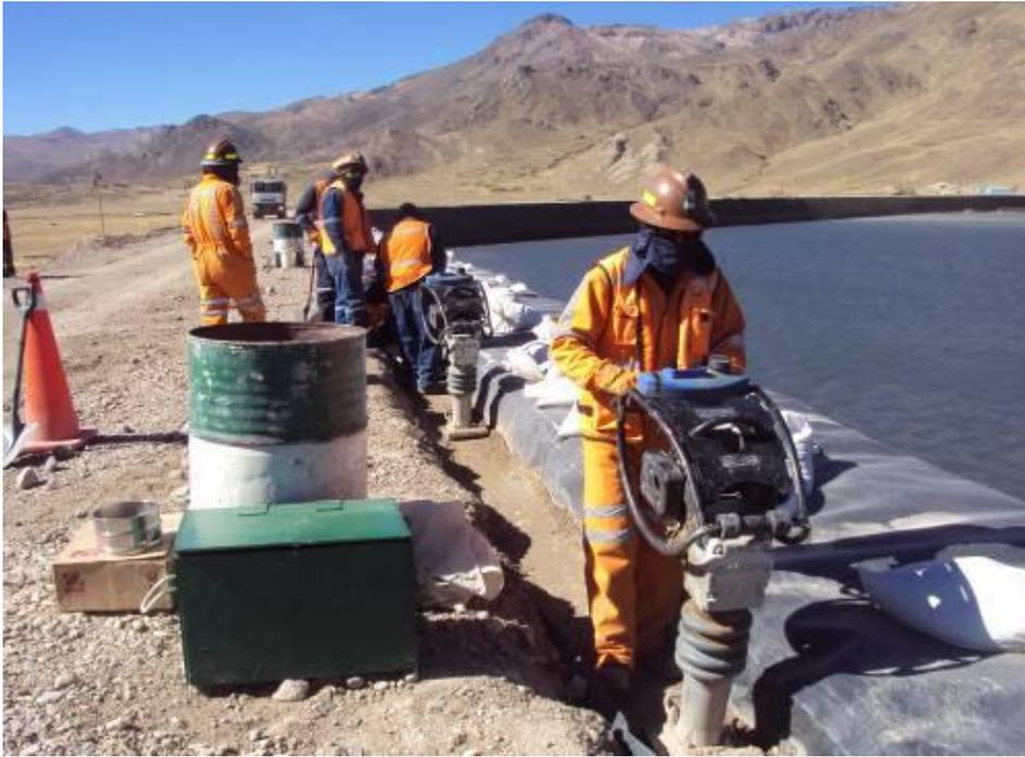
Fotografía 58: Ensayos de densidad con cono de arena en relleno de zanjas de anclaje.
