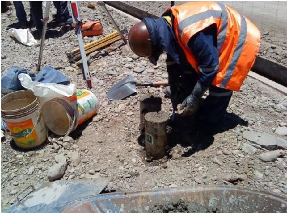
Fotografía 12: Zona de nuevo buzón de concreto para el subdrenaje, se observa el “puente” de geomembrana que deriva el agua del sistema al medio ambiente
