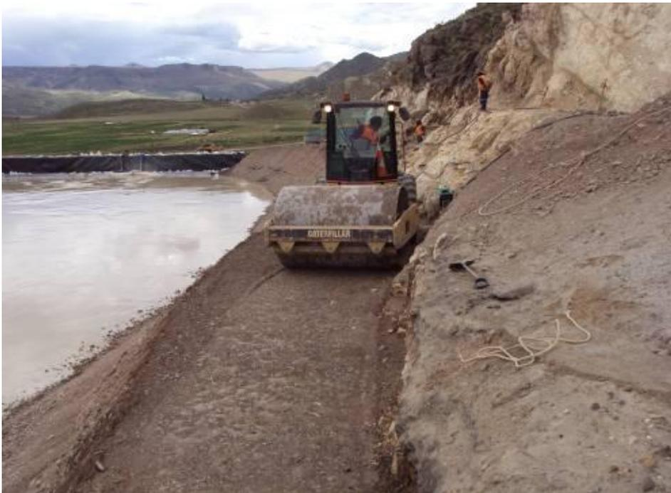
Fotografía 45: Compactación del borde del relleno reforzado en la zona Norte, se utilizan planchas compactadoras.
