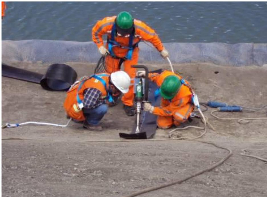
Fotografía 31: técnico QC Amanco durante evaluación de prueba de vacío.
