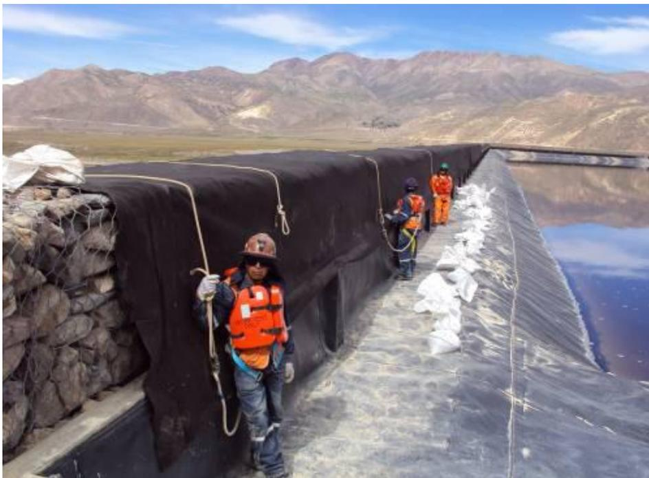
Fotografía 40: Colocación de encofrado en el muro reforzado – dique norte.
