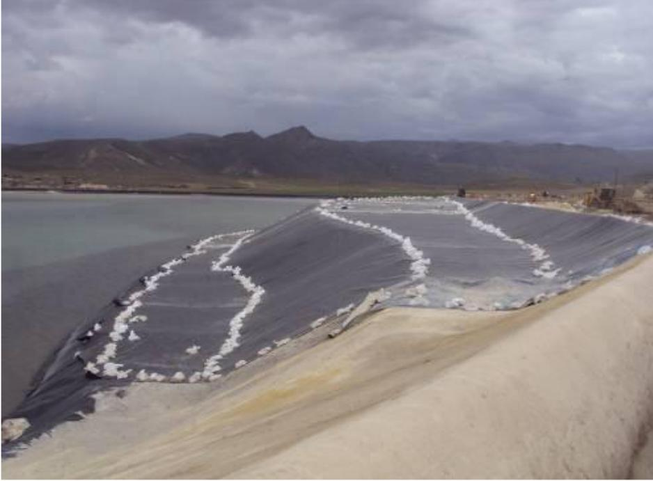
Fotografía 38: Vista general de la zona Sur, se puede observar el nivel de avance más cerca de la corona del Dique.
