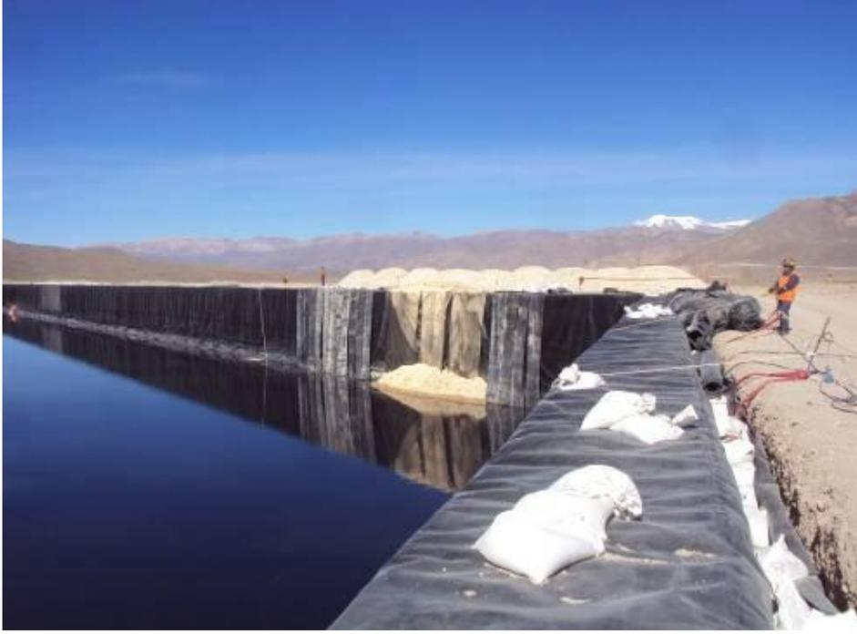
Fotografía 54: Despliegue de GCL y geomembrana en la zona Este bajo el talud de roca.
