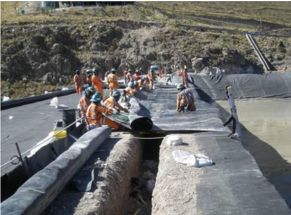
Fotografía 57: Compactación en rellenos de zanja de anclaje - zona oeste.
