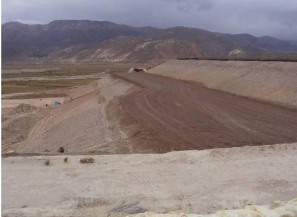
Fotografía 39: Despliegue de geotextil y geomembrana en zona Sur sobre gaviones.
