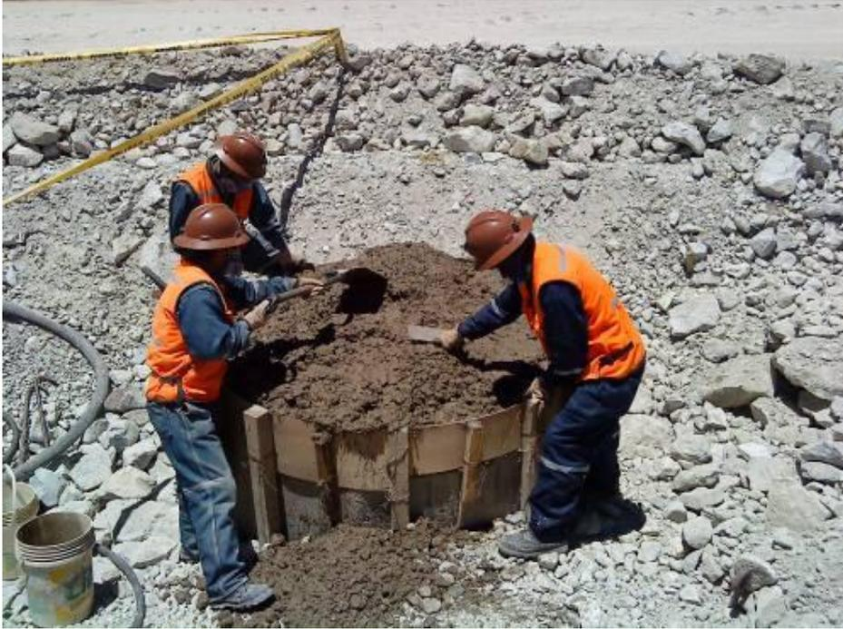
Fotografía 11: Obtención de probetas de concreto para su posterior ensayo de resistencia a la compresión
