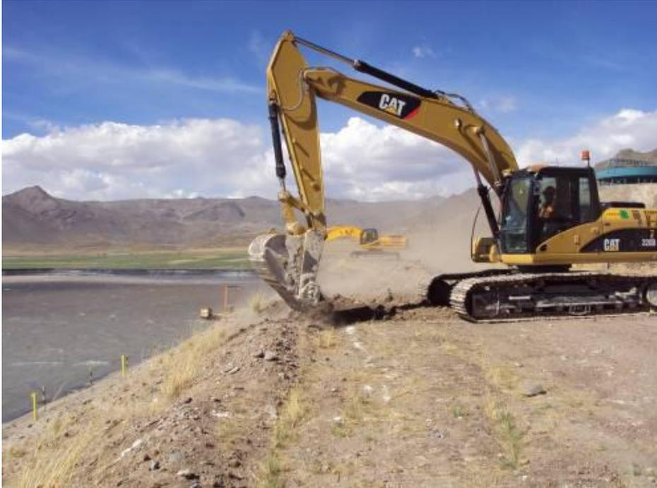
Fotografía 21: Vista de los trabajos de corte en roca en la zona Noreste. Se colocó una protección de geomembrana para evitar daños en el revestimiento del depósito.
