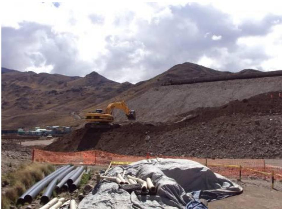
Fotografía 23: Armado, colocación y relleno de gaviones.
