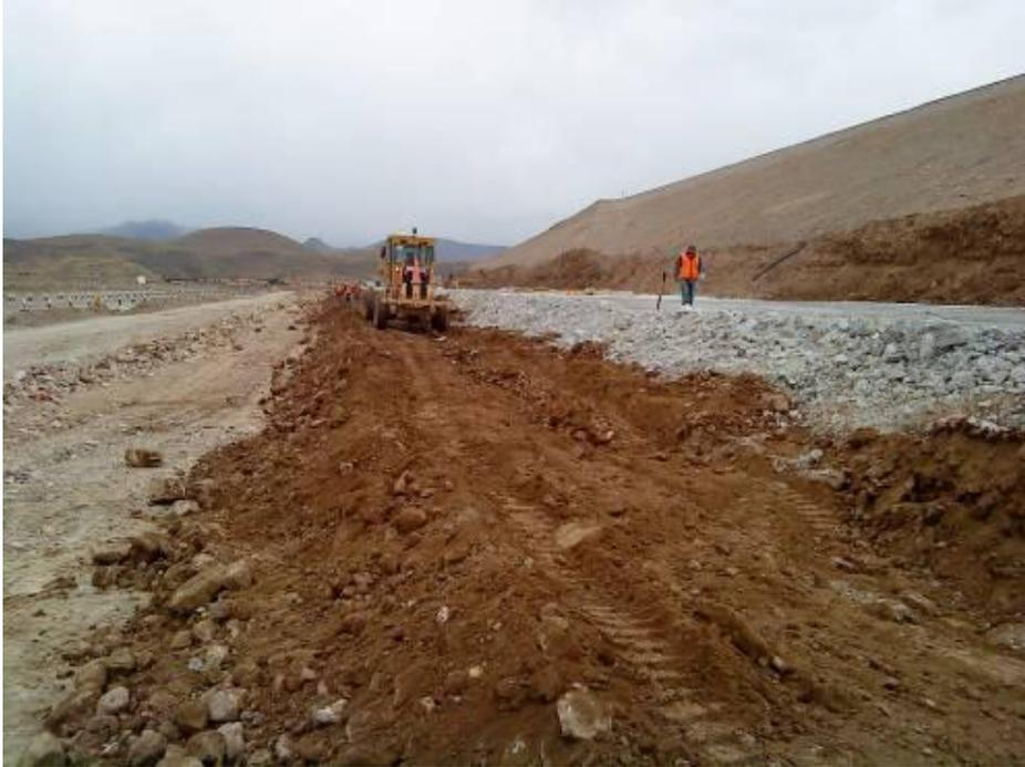
Fotografía 9: Reconformación de la cuarta capa de material de baja permeabilidad en la zona noroeste luego de retirar material de sobre tamaño.
