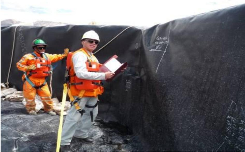
Fotografía 48: Llenado de gaviones en la zona sur, se indica verificar la cara interna pues será la superficie para el despliegue de la geomembrana.
