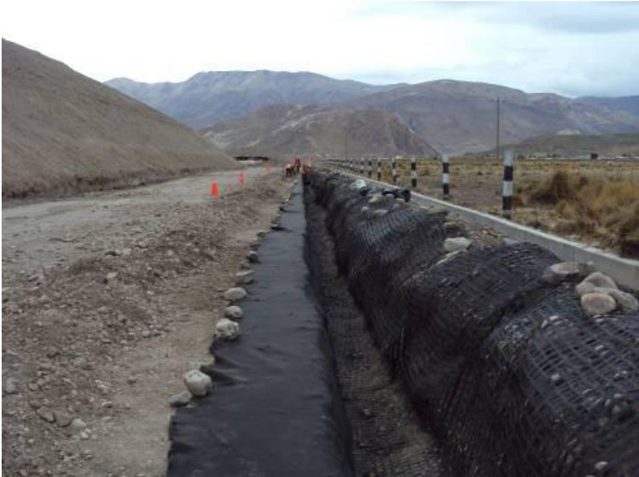
Fotografía 19: Puesta en obra del rollo de geosintético
