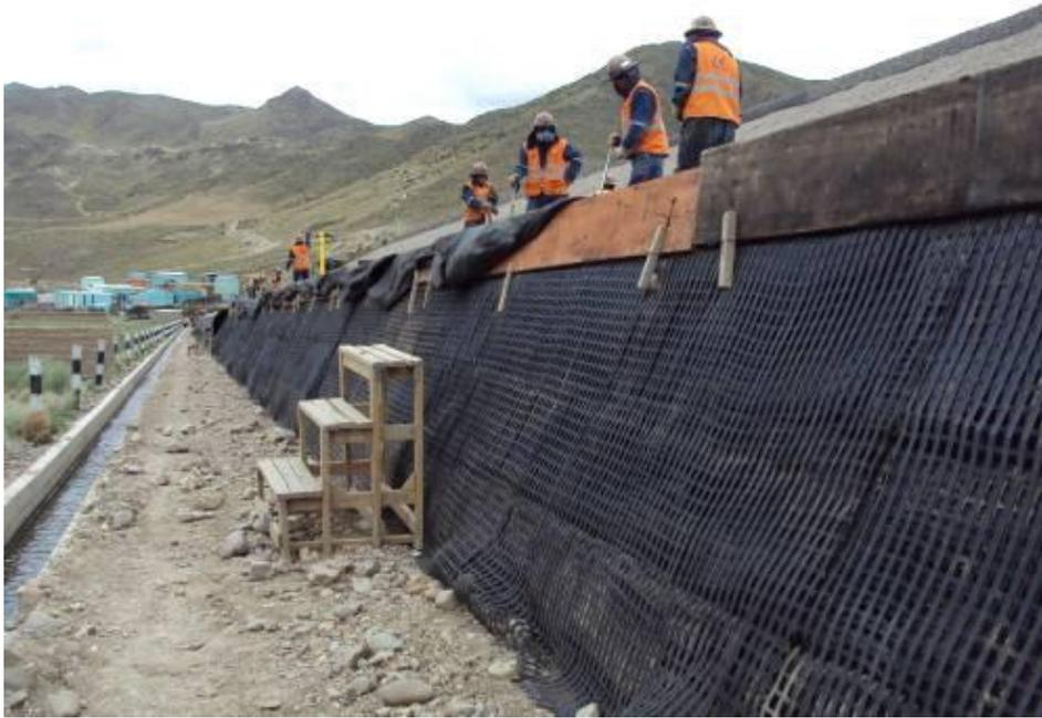
Fotografía 41: Realización de prueba de soldado por extrusión sobre superficie de gaviones
