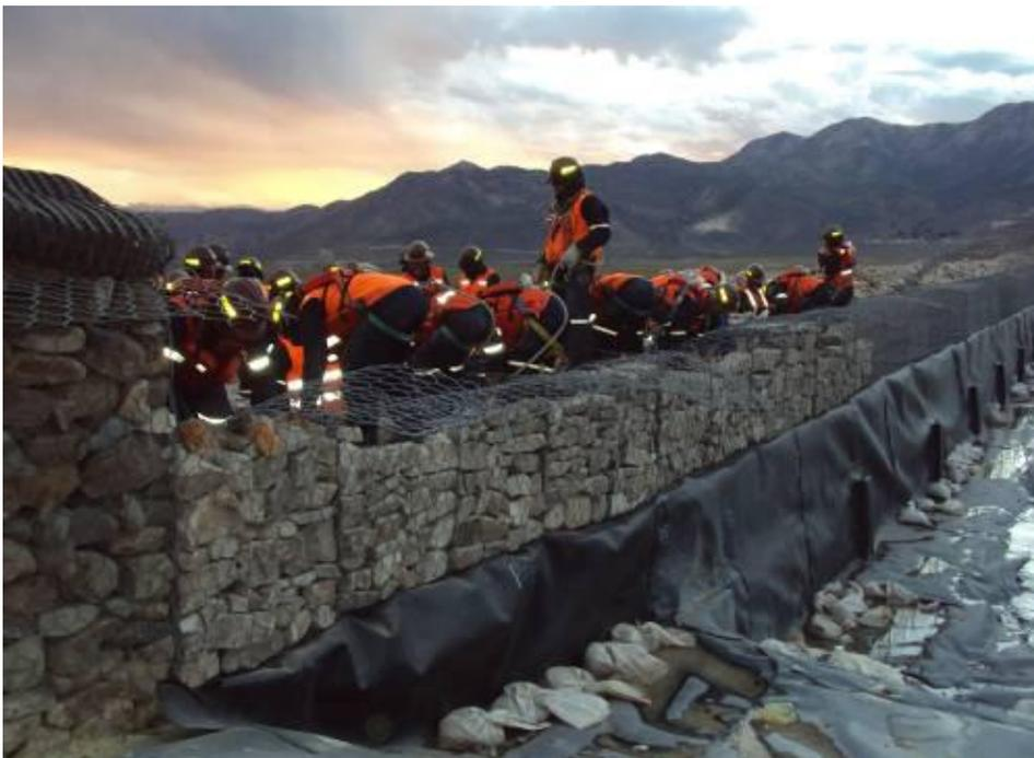
Fotografía 49: Despliegue de geotextil y geomembrana en el lado sur por parte del instalador de geosintéticos Amanco.
