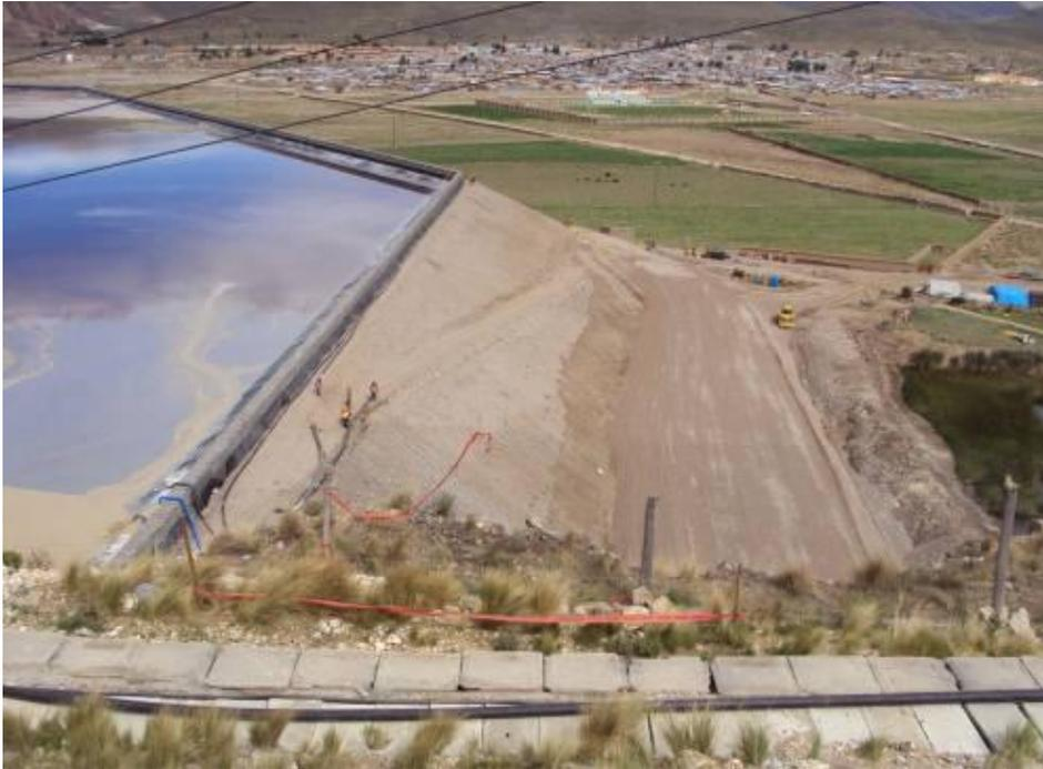
Fotografía 43: Vista general de los trabajos de despliegue de geomembrana en las zonas Norte y Noreste.
