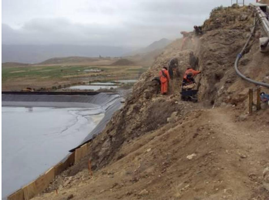
Fotografía 22: Conformación de material de baja permeabilidad en la esquina norte/noroeste.
