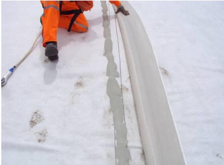
Fotografía 34: Despliegue geomembrana luego de la aprobación del GCL.
