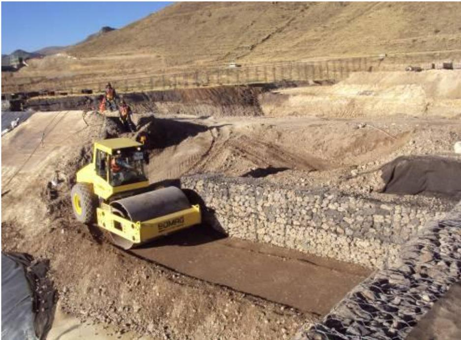
Fotografía 61: Colocación de material de relleno en la zanja de anclaje en la zona Norte y Noroeste.
