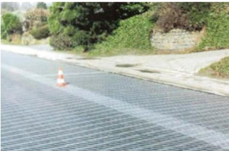
Figura 0.67: Malla de Acero de Refuerzo
