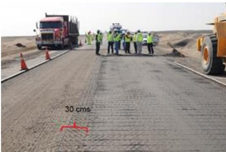
Figura 0.12: Colocación del Slurry Seal
