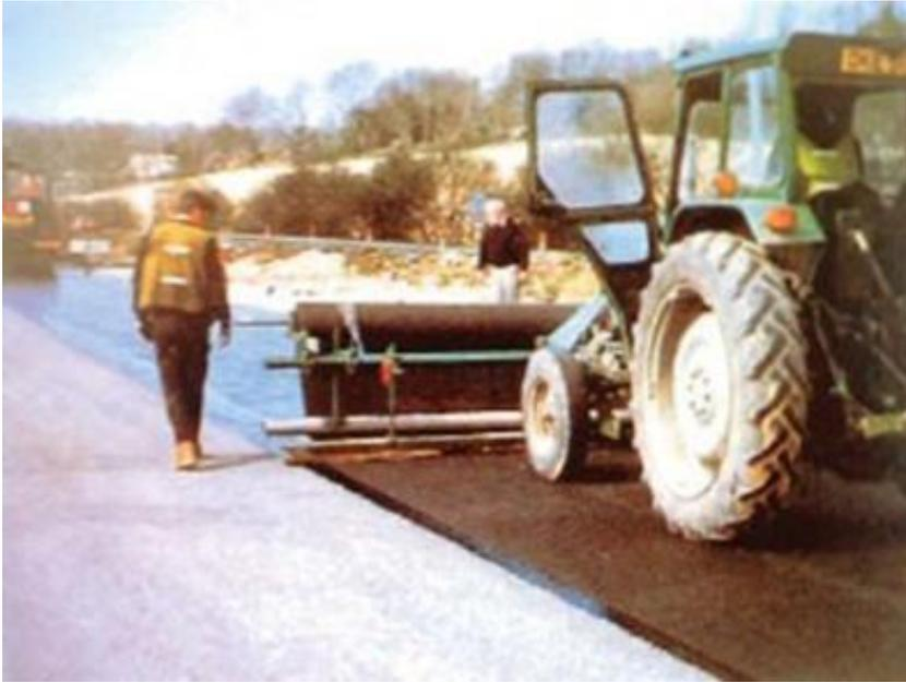
Figura 0.59: Equipo para la extensión de mezcla
