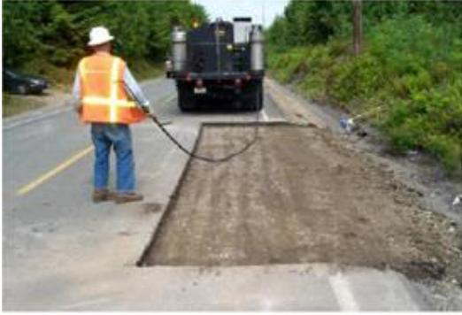
Figura 0.8: Preparación del área a bachear y compactación de la capa colocada
