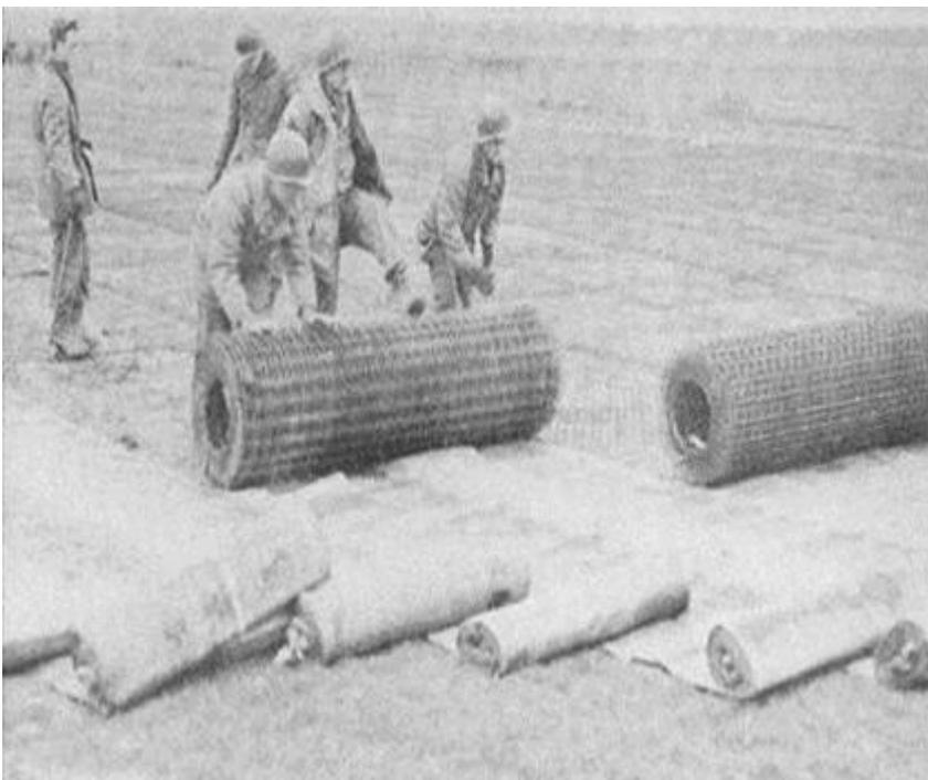
Figura 0.42: Malla de Acero, usada por la Armada de Estados Unidos
