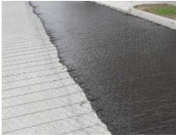
Figura 0.57: La aplicación del Slurry Seal es para obtener una buena adhesión a la capa subyacente
