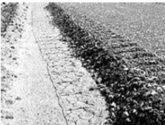
Figura 0.61: Colocación de la carpeta de Concreto Asfáltico
