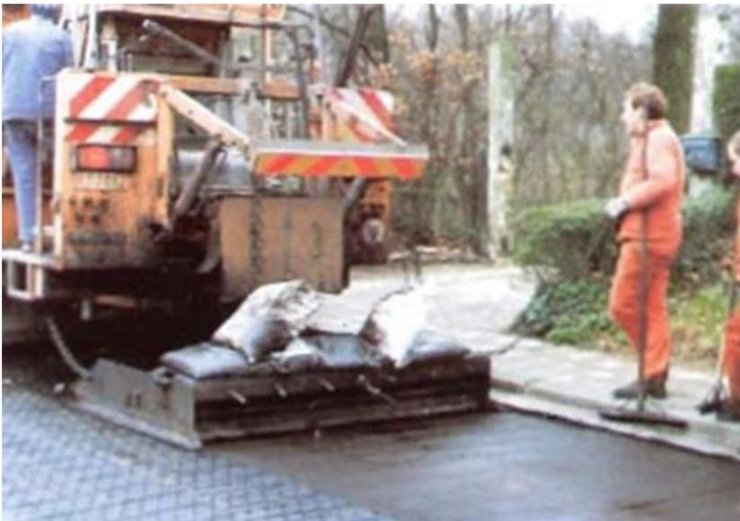
Figura 0.60: Equipo para colocación de Slurry
