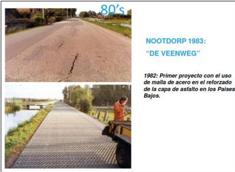
Figura 0.33: Primer Proyecto con el uso de malla de acero en el reforzado de la capa de asfalto en los países bajos.
