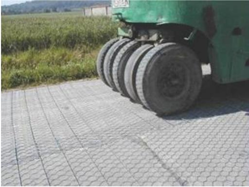
Figura 0.54: Aplanado de la Malla Metálica
