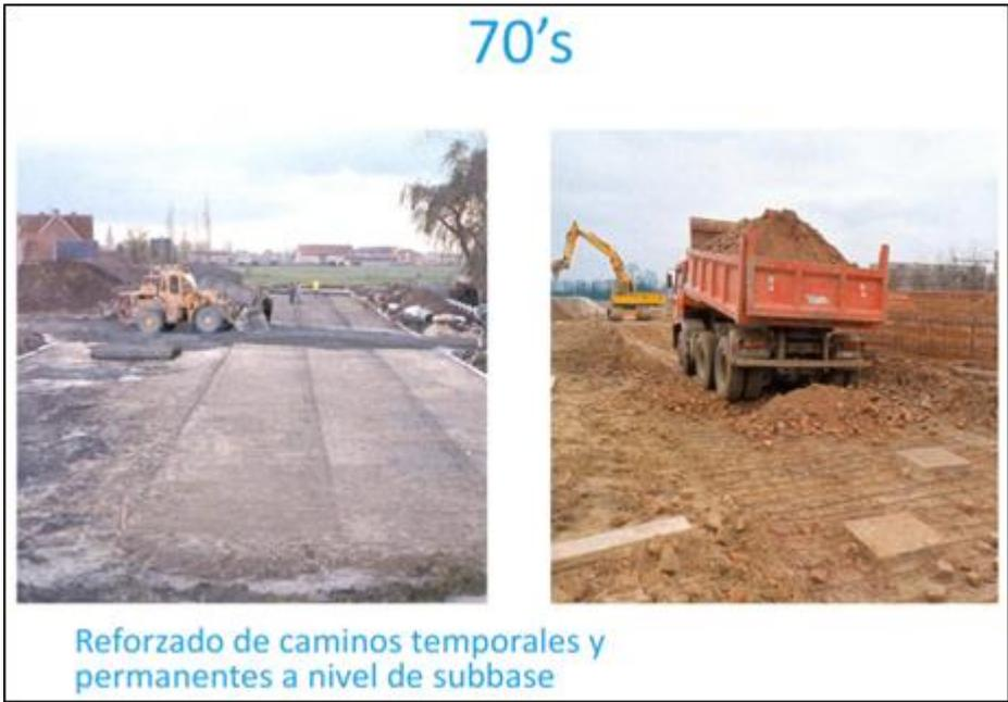
Figura 0.31: Reforzado de caminos temporales y permanentes a nivel de subbase
