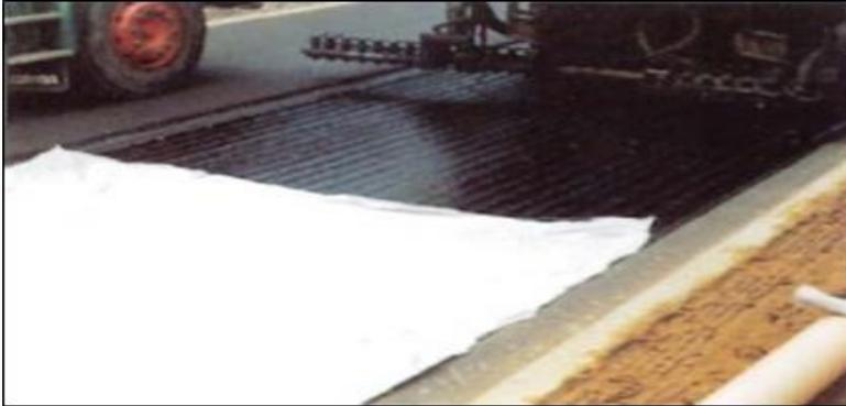
Figura 0.64: Aplicación de geotextil no tejido sobre el aglutinante previamente regado
