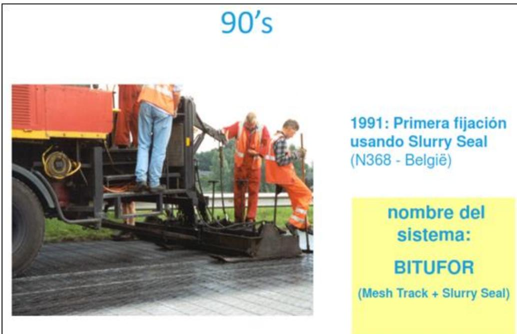
Figura 0.34: Primera fijación usando Slurry Seal, Sistema Bitufor (Mesh Track + Slurry Seal)
