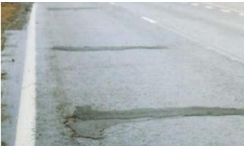
Figura 0.62: Agrietamiento por reflexión
