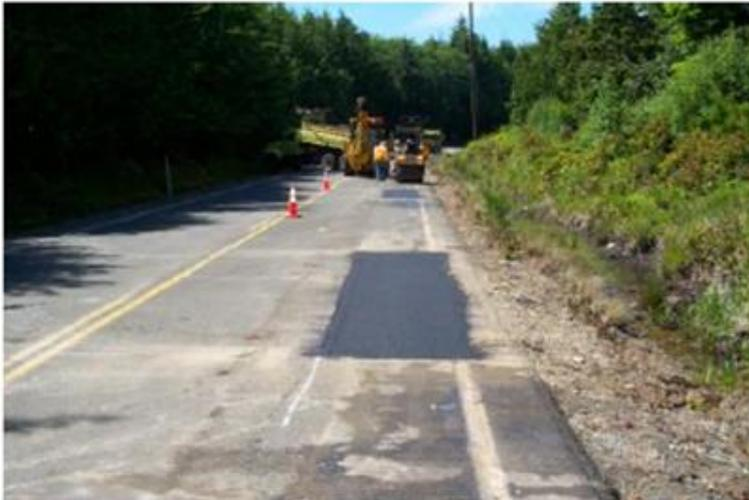
Figura 0.9: Relleno de zonas de Ahuellamiento
