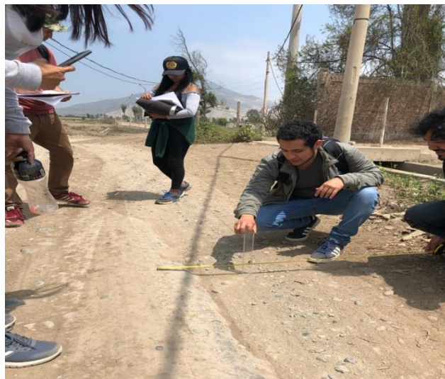
Figura N° 74: Medición de la falla
