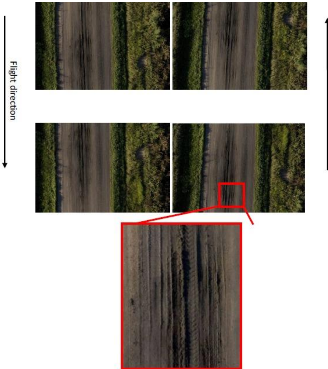
Figura N° 43: Detalles de la superficie de la carretera
