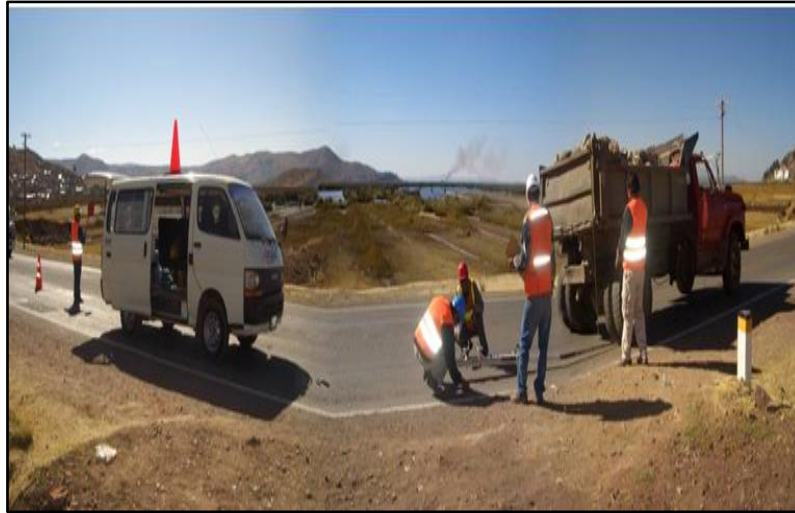
Figura N° 160: Condición Estructural del pavimento
