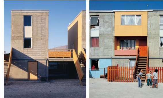
Figura 26. Palma, C. (03-05). [Quinta Monroy]. Laboratorio de la vivienda sostenible, Barcelona. http://laboratoriovivienda21.com/magazine/?p=133
