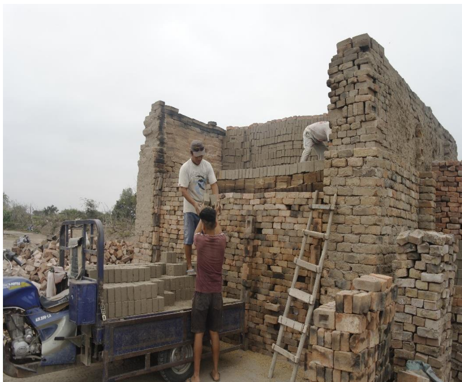
Fotografía N° 13: Colocación del Ladrillo en el horno
