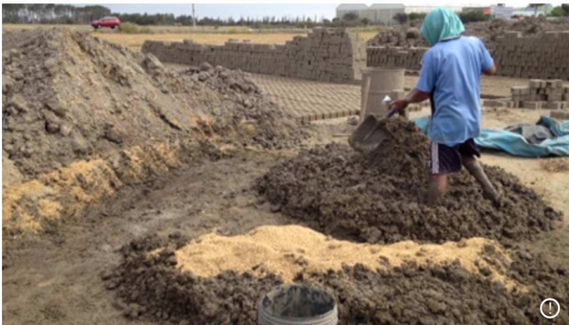
Fotografía N° 36: Mezclado de los materiales antes del moldeado de los ladrillos
