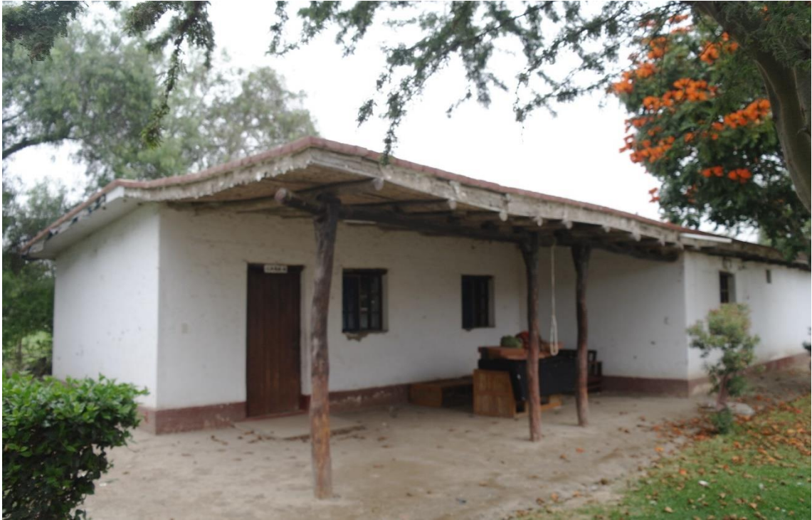
Fotografía N° 54: Casa de adobe en el Distrito de Monsefú.
