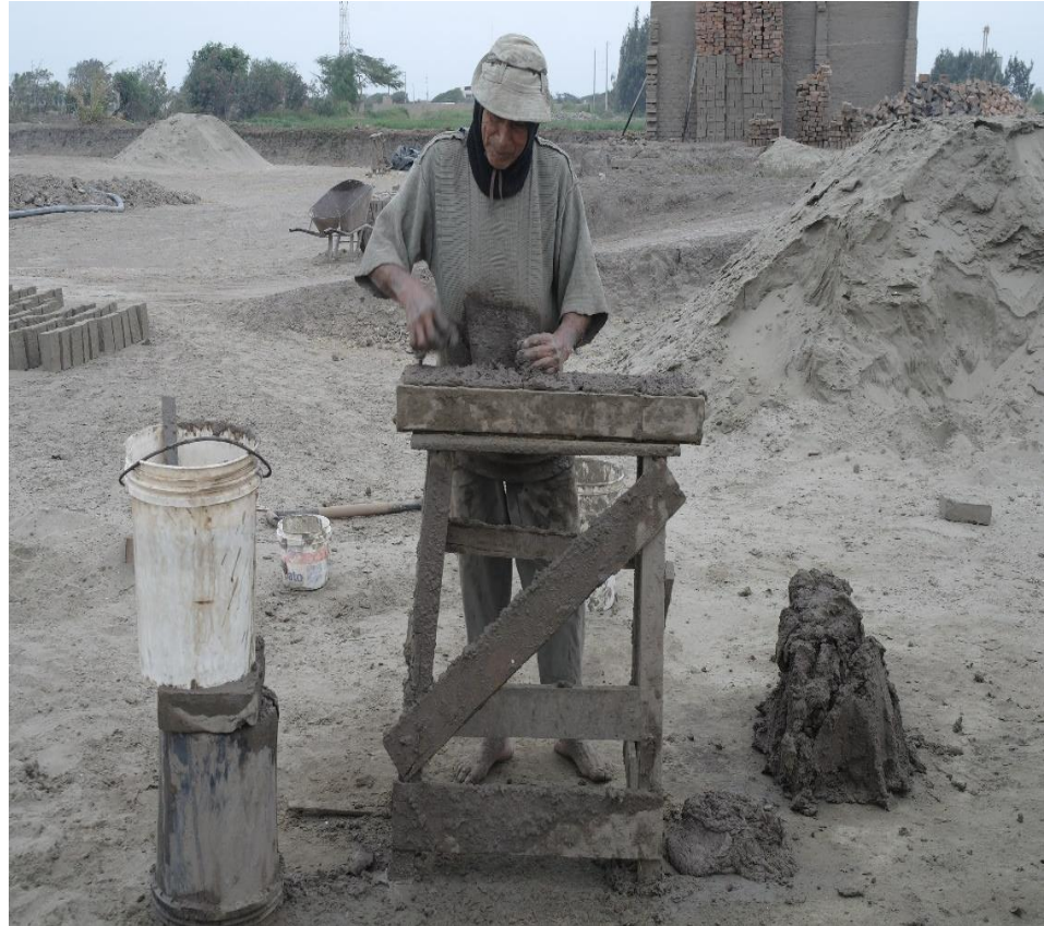
Fotografía N°10: Moldeado del ladrillo
