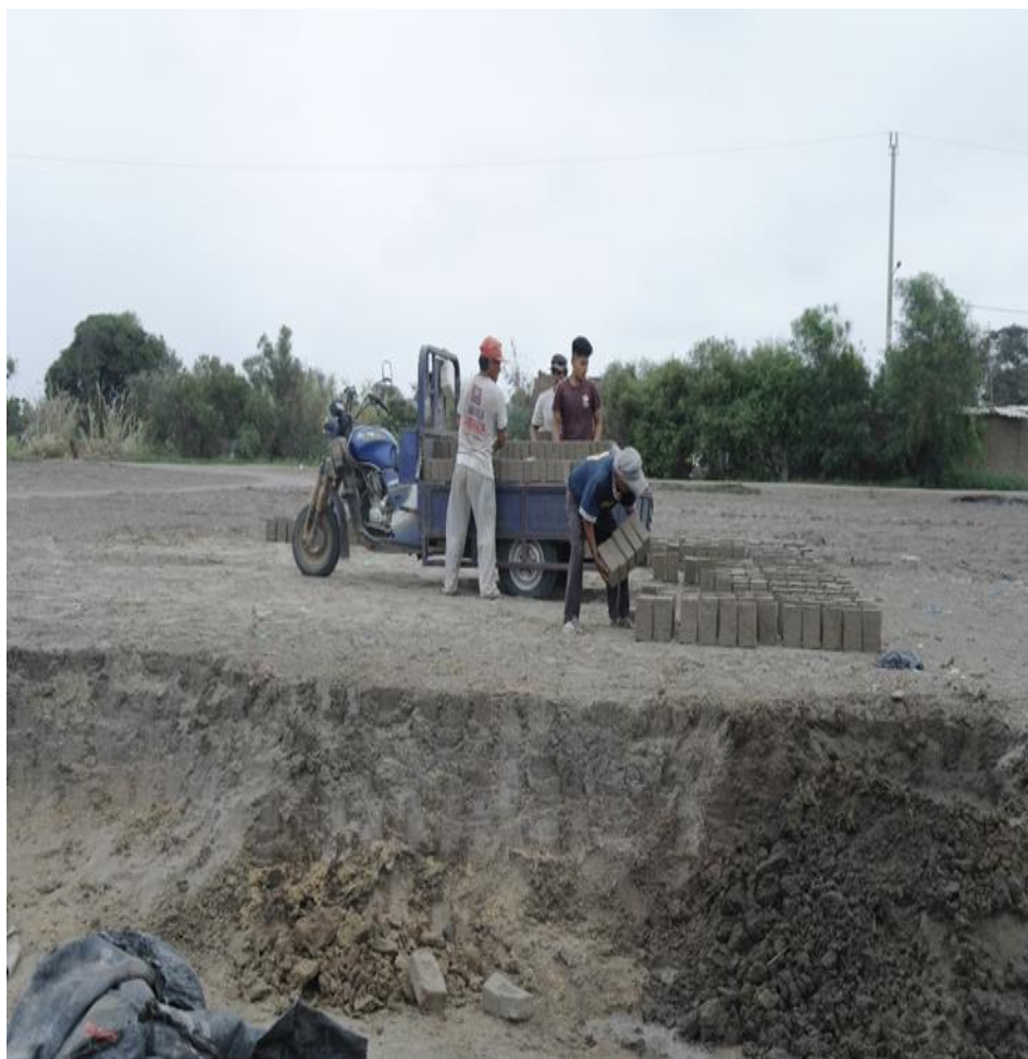
Fotografía N° 12: Carga del material
