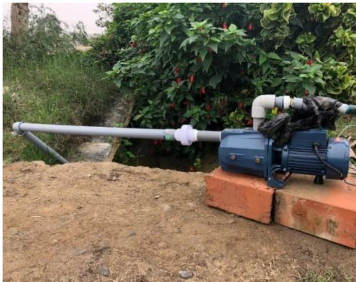
Figura N° 64: Bomba eléctrica extrayendo agua del canal
