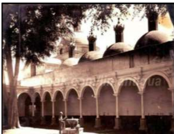
FIGURA N°7: Foto del Claustro Local central de la Av. Bolívar
