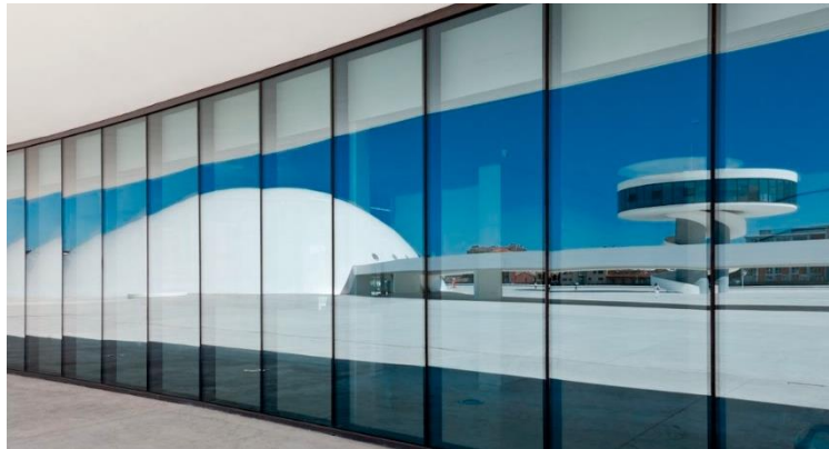
Figura 14: Cerramientos del Centro Cultural O.
