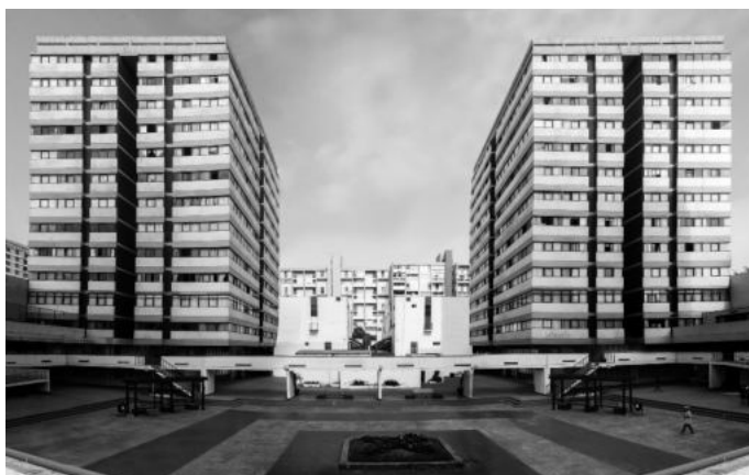
Imagen 8: Vista actual del complejo residencial. Fuente: https://es.slideshare.net/MaaMuuT/residencial-san-felipe-75585222 . Año 1964.
