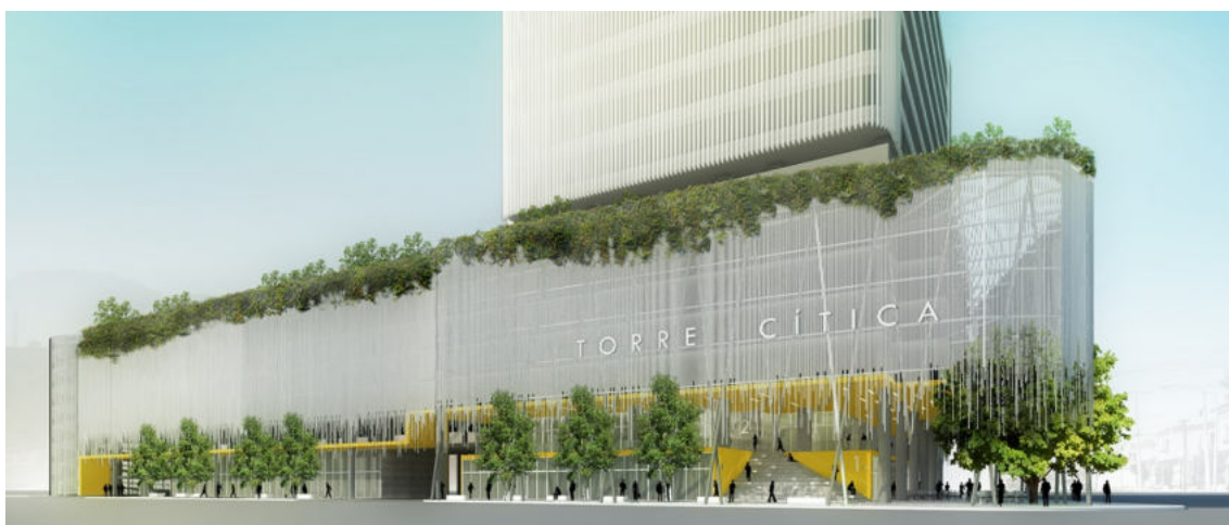
Imagen 23: Parte inferior externa de la torre. https://www.skyscrapercity.com . Año: 2009.
