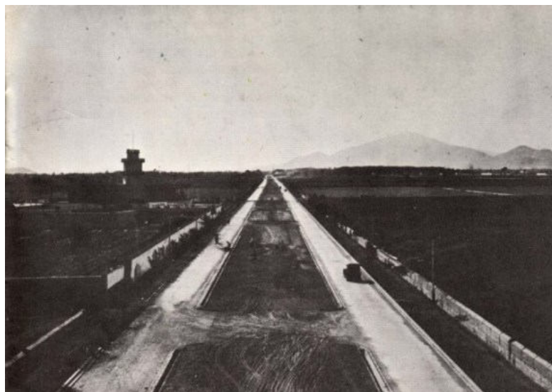
Imagen 35: Vista panorámica de la avenida Leguía durante su construcción. Fuente: http://www.arkivperu.com . Año 1921.
