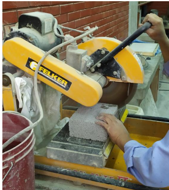
Figura 20: Corte de bloque de concreto
