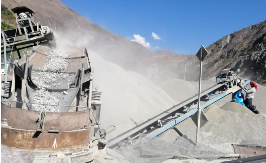
Figura 9: Proceso de trituración y clasificación de residuos de construcción Fuente: Elaboración propia
