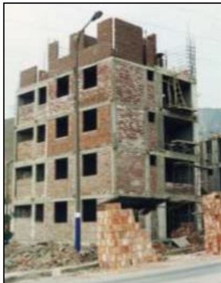
Figura 1: Edificación de albañilería confinada.
