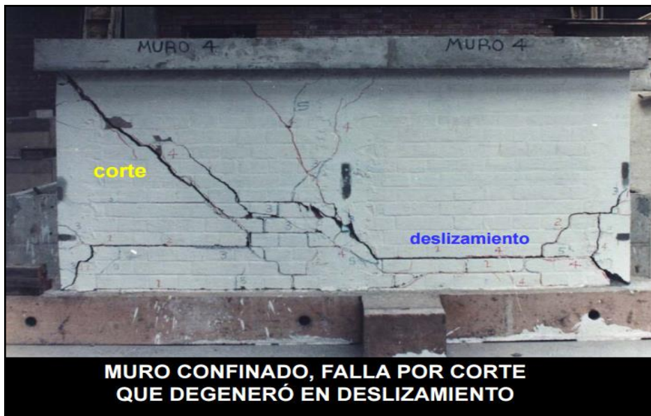
Figura 2: Muro de albañilería confinada, falla por corte que degeneró en deslizamiento. Fuente: Diseño estructural de una edificación de albañilería confinada de 8 pisos en la ciudad de Trujillo, Escamilo, J. (2017).
