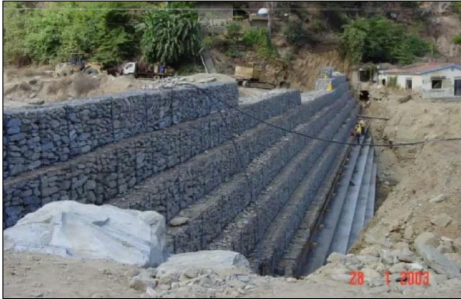
Figura N° 68. Dique de gaviones. Fuente: González F. Ana, 2019.
