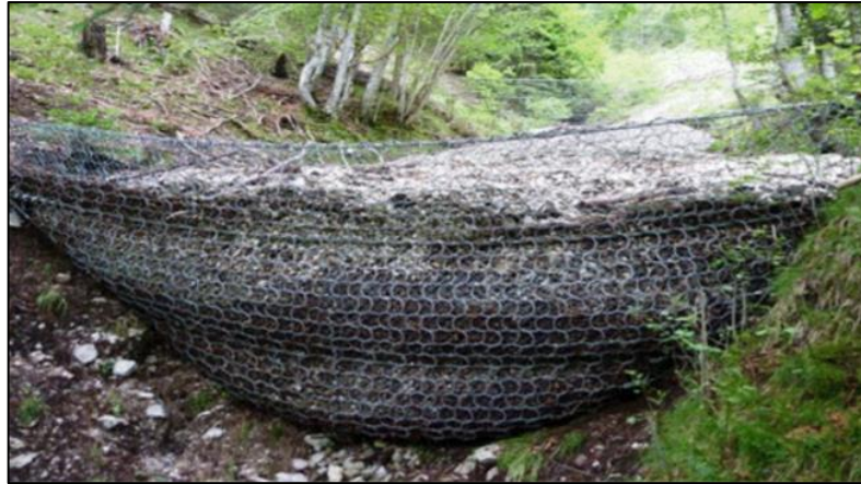
Figura N° 82. Barrera Flexible contra flujo de detritos Fuente: Página web Trumer
