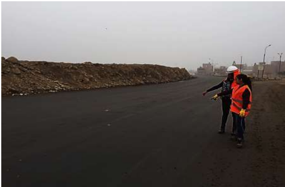
Figura N° 54: Vía de estudio- Acabado final
