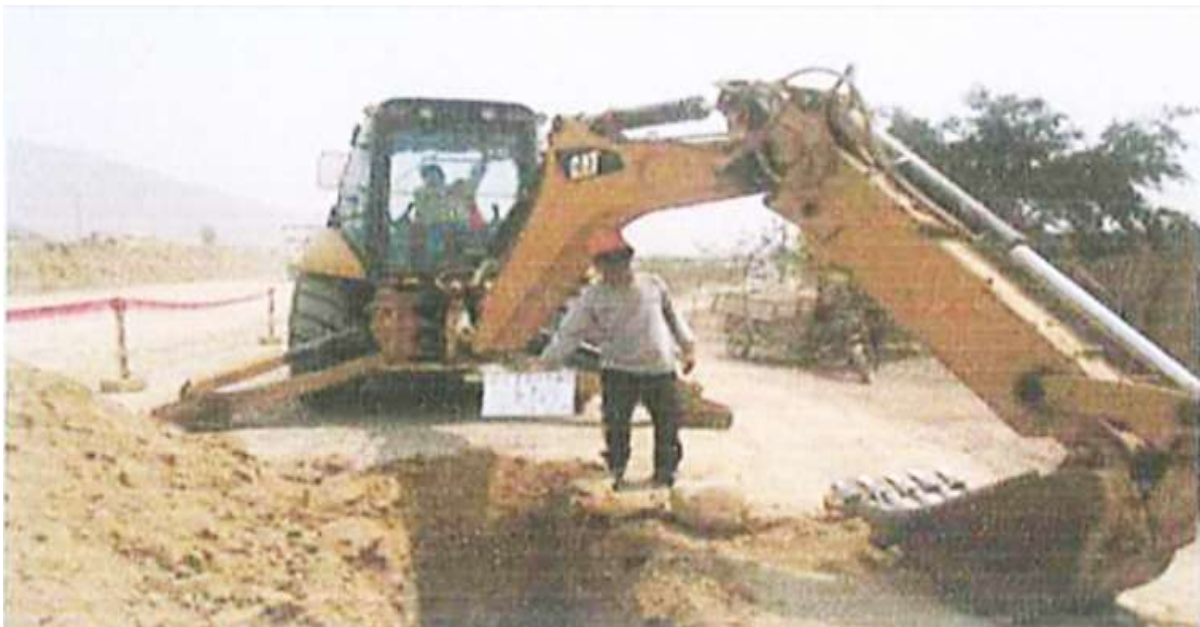
Figura N° 19: Vista de la exploración realizada en la C-1.
