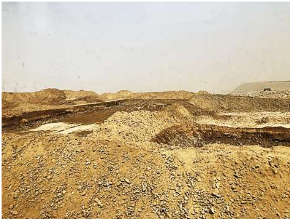
Figura N° 48: Pozos para humedecer material
