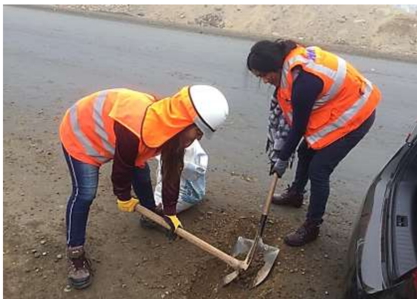
Figura N° 52: Vía de estudio- extracción de la muestra alterada de la base.
