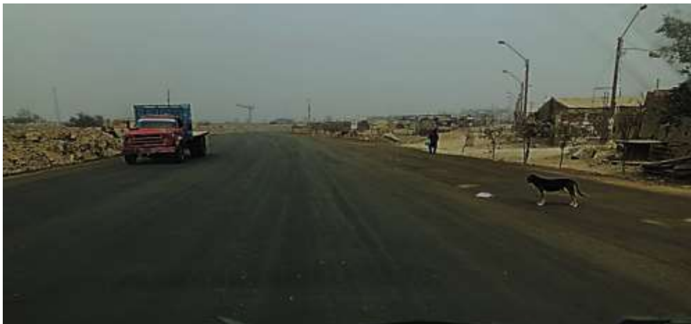
Figura N° 50: Vía de estudio-Base estabilizada
