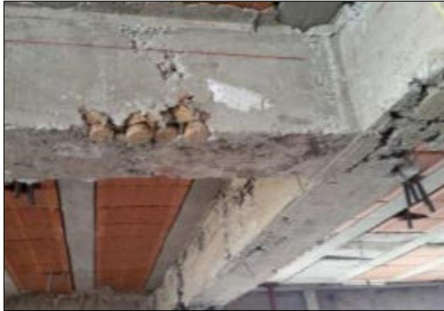
Figura 15: Exposición de tubería en vigas
