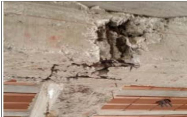
Figura 13: Cangrejeras en vigas de concreto
