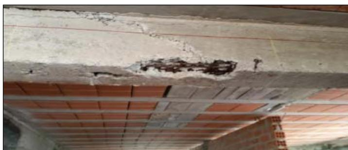
Figura 1: Patologías en la viga de concreto de armado
