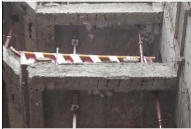
Figura 16: Exposición de Acero en vigas
